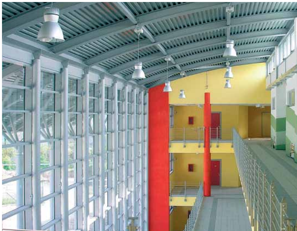
Pic. 54 - Istituto Don Milani, Brescia, illuminazione interna con sensori di accensione e spegnimento automatico
