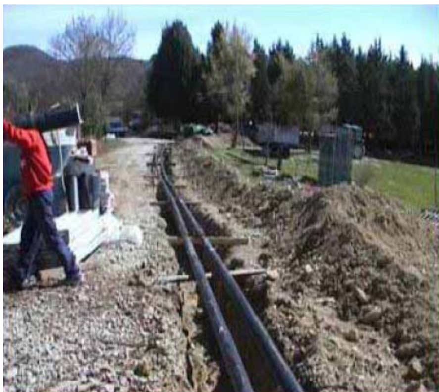
Messa in opera della rete di teleriscaldamento
