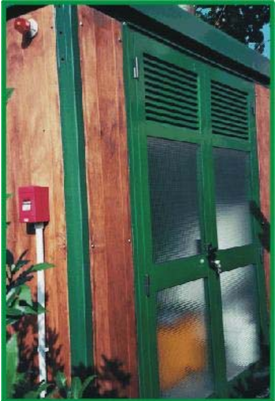
Vista frontale con ingresso
