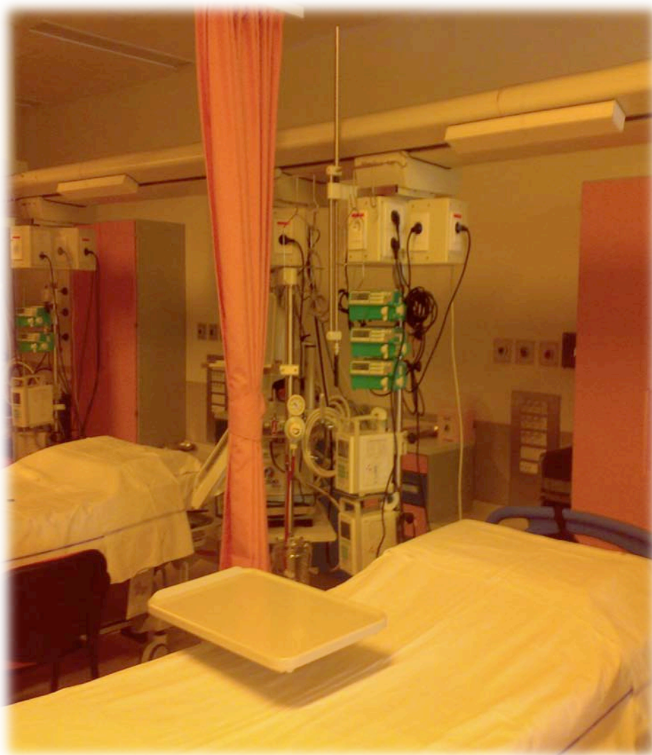
Figura 43. Antenna ad otto patch posizionata sulla trave testaletto (visibile centralmente su ogni letto)
