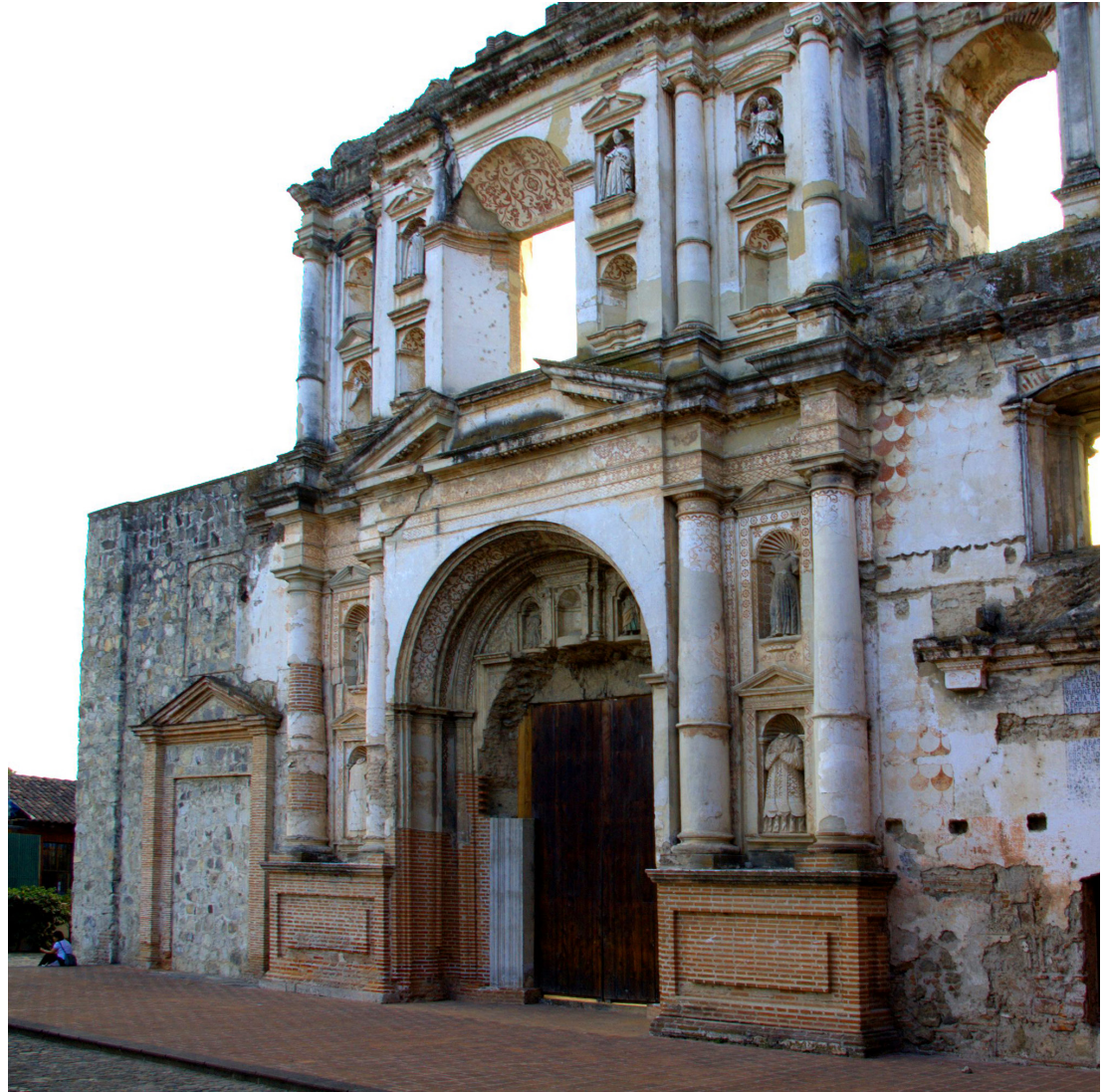
1. La facciata della chiesa della Compañía de Jesús dopo i recenti interventi di consolidamento.
