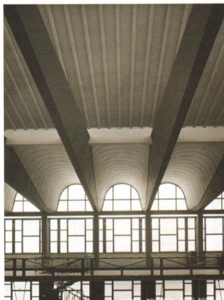
Figura 10 - Vista fotografica del salone verso la facciata del lato ospedale (Archivio CRF)
