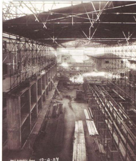
Figura 17 – Cantiere, vista fotografica della fase di edificazione del salone interno (Archivio CRF)
