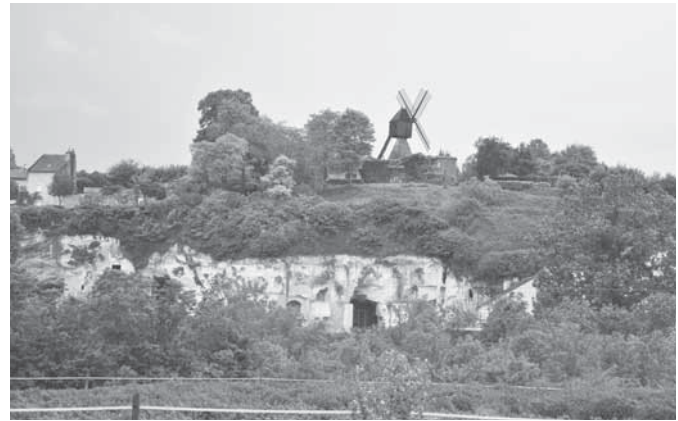
Fig. 7 Turquant hillside général vue from the valley.
