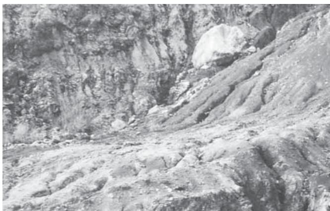
Fig. 5 Quesa. Comunidad Valenciana. El Cerro Negro. Erosión rgrooves and gullies in Triassic clay.
