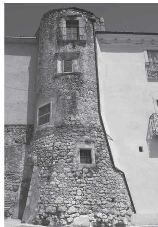
Fig. 9-12 Rocca Calascio. Sopra: fronte posteriore; a fianco in alto: vista della rocca e del borgo; a fianco in basso: rispettivamente paramento del corpo centrale in conci squadrati, muratura della cinta esterna in bozze a corsi irregolari.
