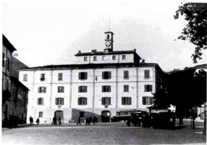
10. Palazzo dell'Intendenza di Finanza, lato viale E. Chiesa. L'edificio è stato demolito negli anni sessanta per costruire l'attuale Palazzo Comunale. (foto d'epoca, anni trenta).
