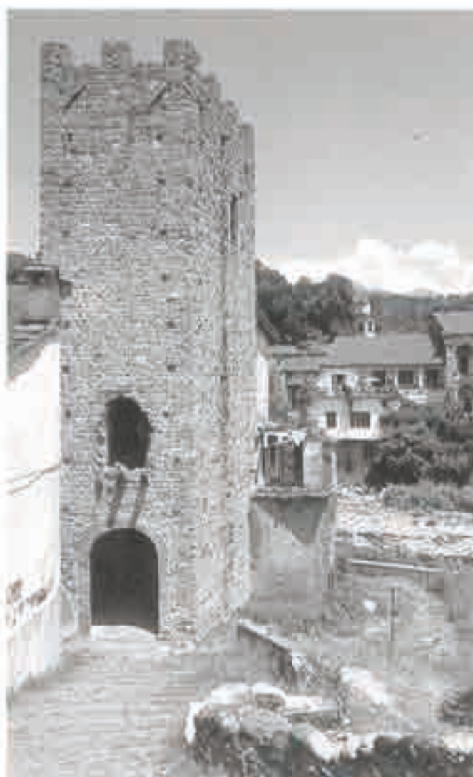
Pontremoli. La torre quadrilatera presso la porta del Castello.
