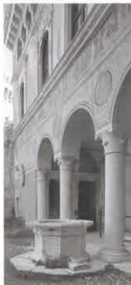
Missa, castello Malaspina: a destra, il castello interno; sopra, un particolare del loggiate superiore.
