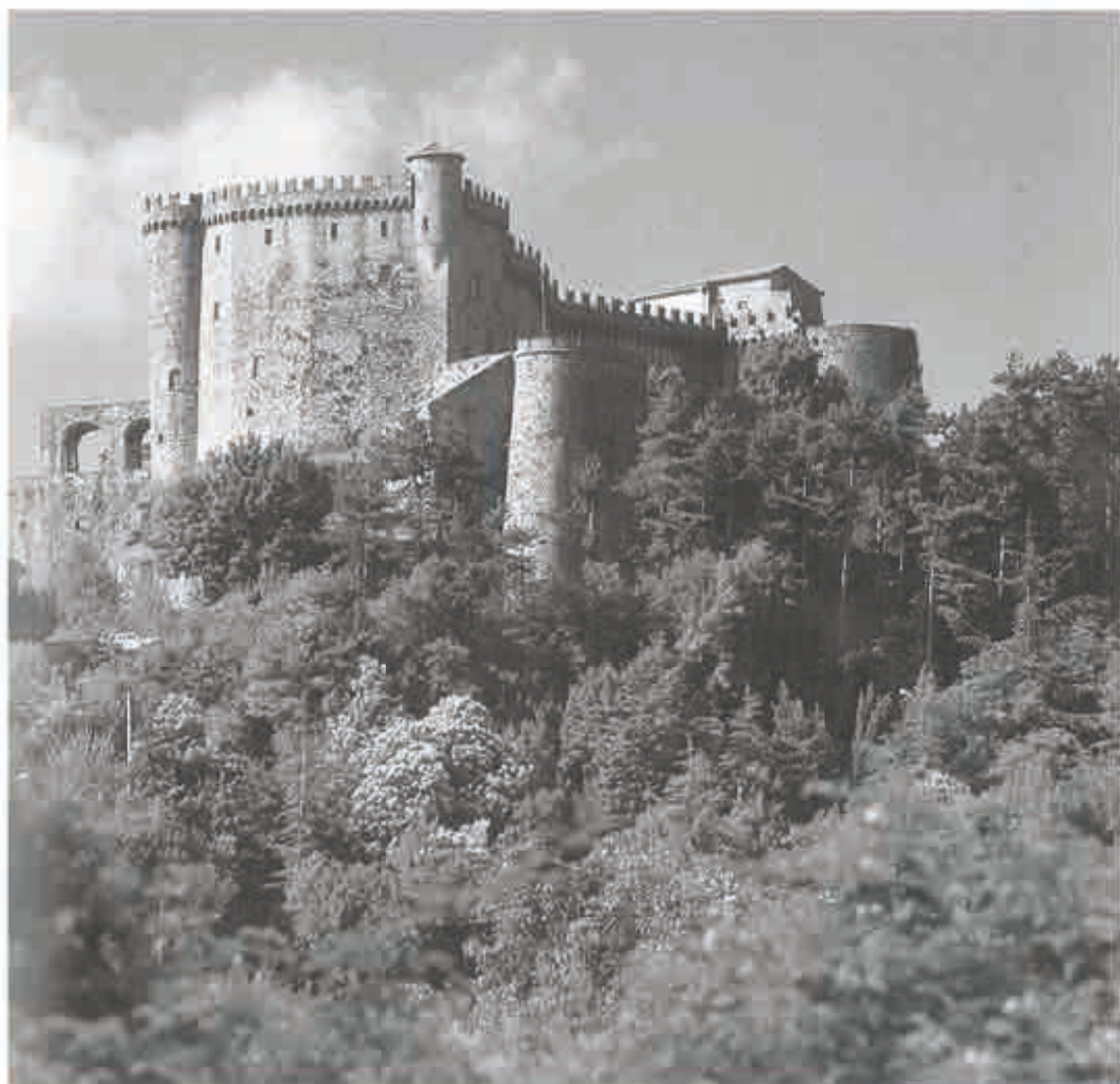
Il castello multiprotagonista di Fontenore, di impianto trecentesco, deve il suo attuale aspetto a rifacimenti di epoca posteriore.
