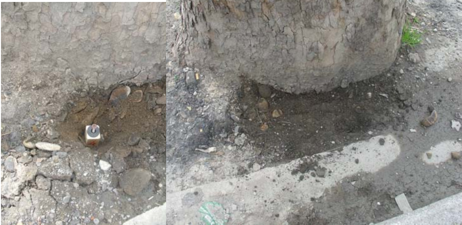
Foto 11.5 Messa in opera di microchip interrati alla base di un albero
