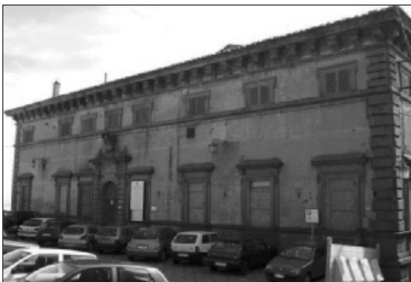
Figura 2 - Palazzo Bourbon-Del Monte (prospetto Nord).
