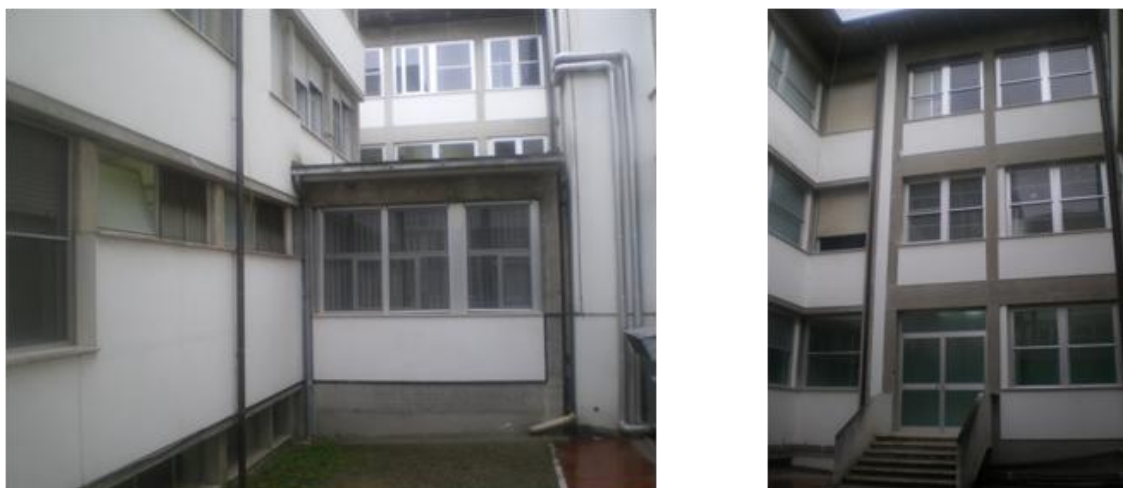
Figura 5.16: Unità strutturali 5 e 6
