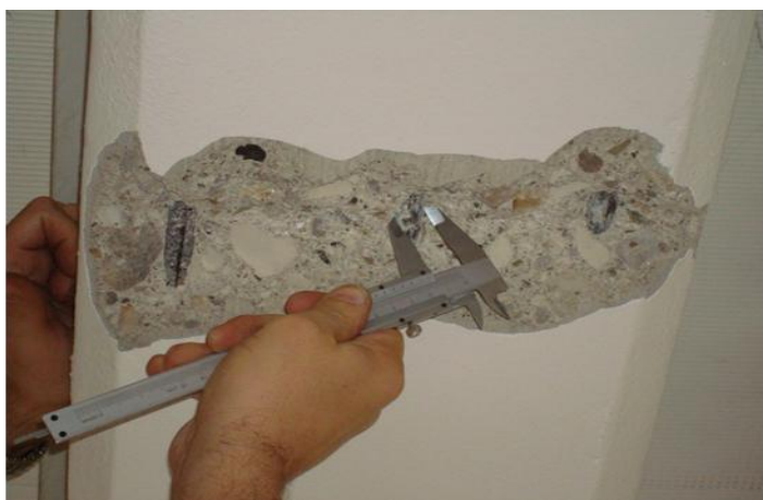
Figura 5.50: Verifica delle barre d'armatura mediate calibro
