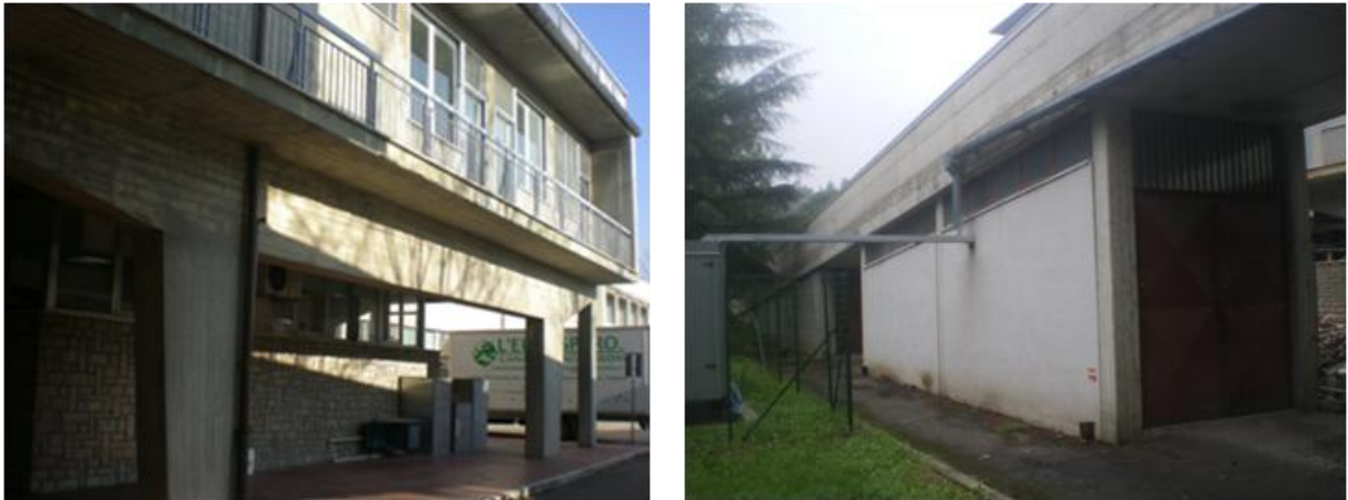
Figura 5.21: Unità strutturali 15 e 16
