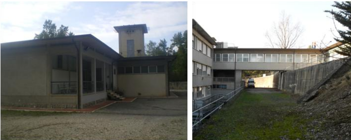
Figura 5.20: Unità strutturali 13 e 14
