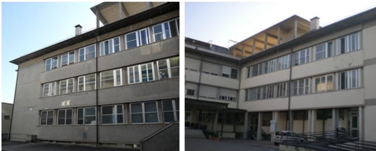
Figura 5.14: Unità strutturali 1 e 2
