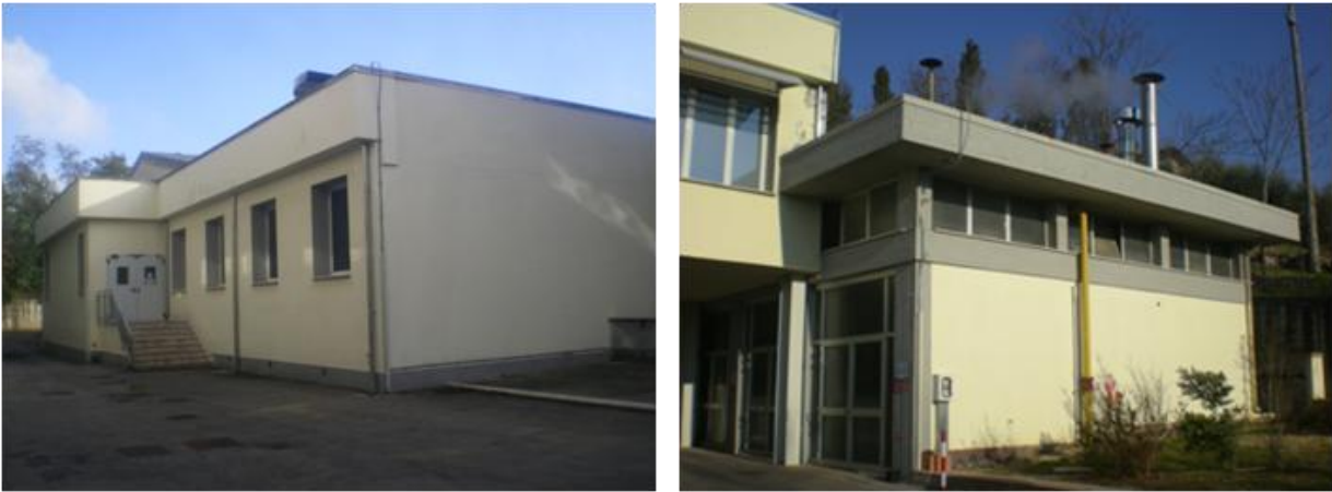
Figura 5.19: Unità strutturali 11 e 12
