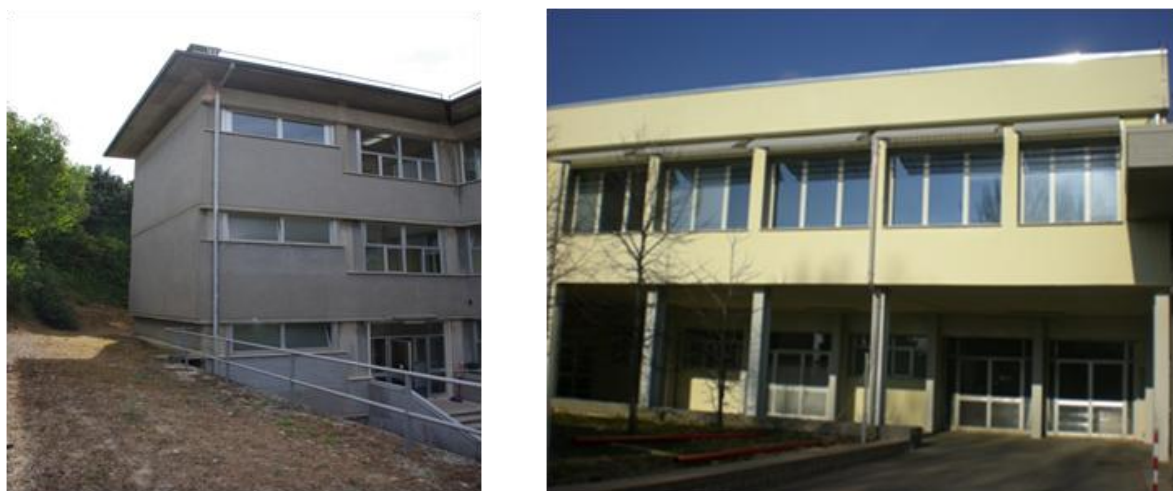
Figura 5.18: Unità strutturali 9 e 10
