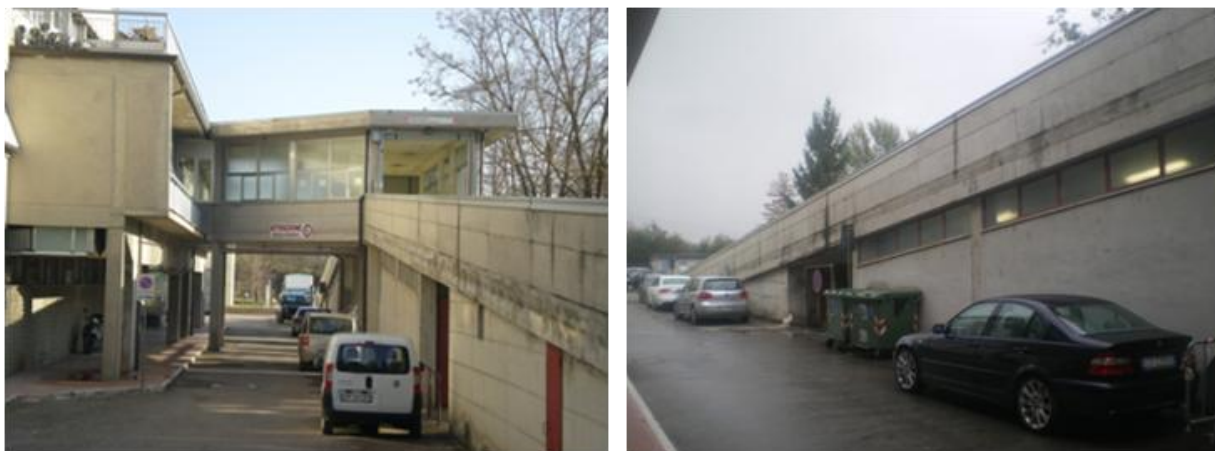
Figura 5.22: Unità strutturali 17 e 18
