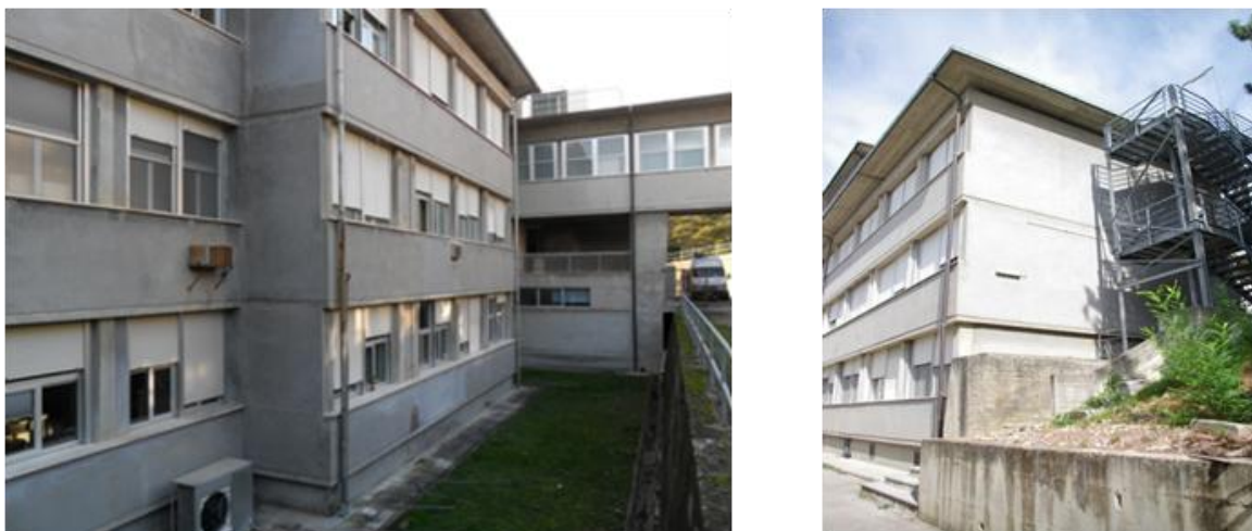
Figura 5.17: Unità strutturali 7 e 8
