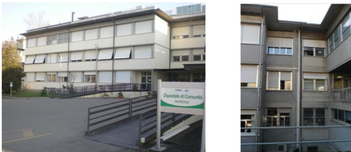
Figura 5.15: Unità strutturali 3 e 4
