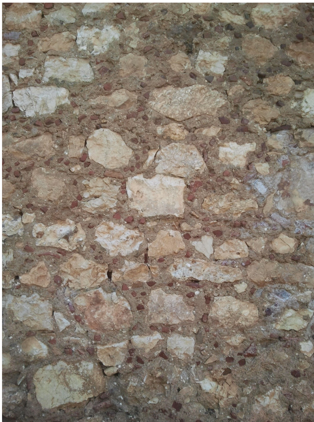
Fig. 36 – Matrice muraria locale con rincocciatura e rabboccatura raso sasso 19
