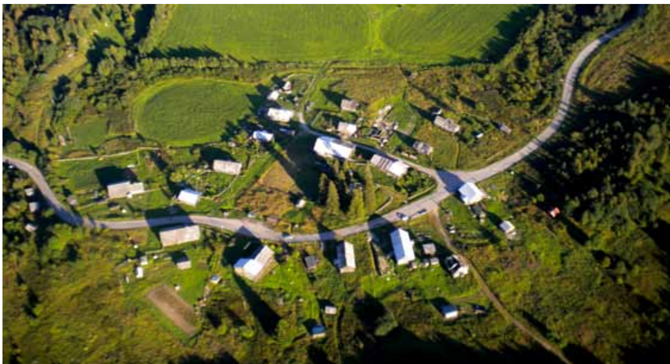
Il villaggio storico di Kinerma, appartenente alla regione di Vedlozero. Rappresenta un tipo di insediamento multidirezionale, nel quale la strada di impianto rappresenta la matrice di riferimento attorno alla quale il villaggio si è sviluppato con andamento per lo più circolare.
