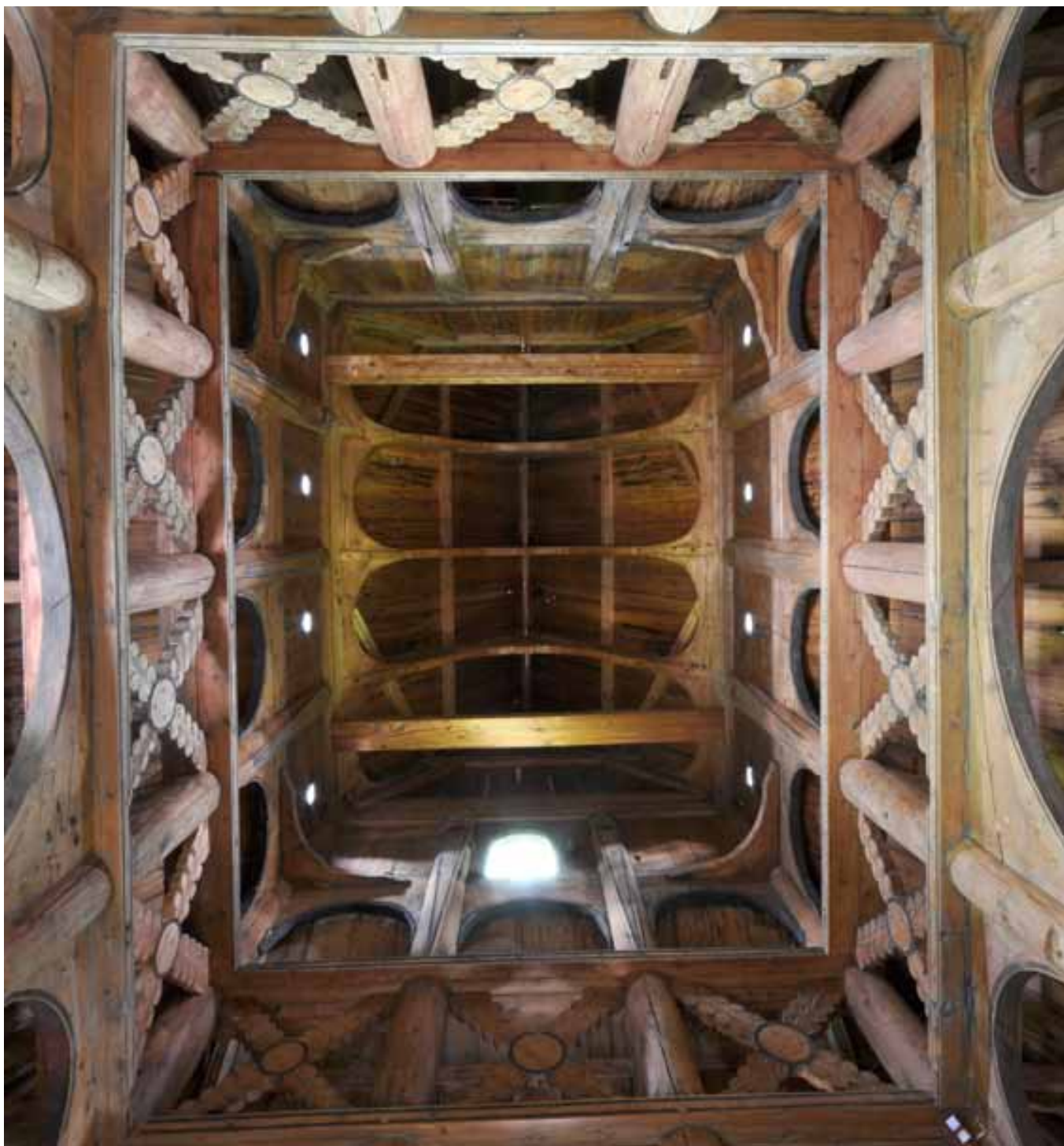
Vista dal basso del sistema costruttivo degli alzati e della copertura della Stavkirke di Borgund, caratterizzata da un evidente influsso romanico fuso con le tecniche costruttive delle chiese locali norvegesi.
