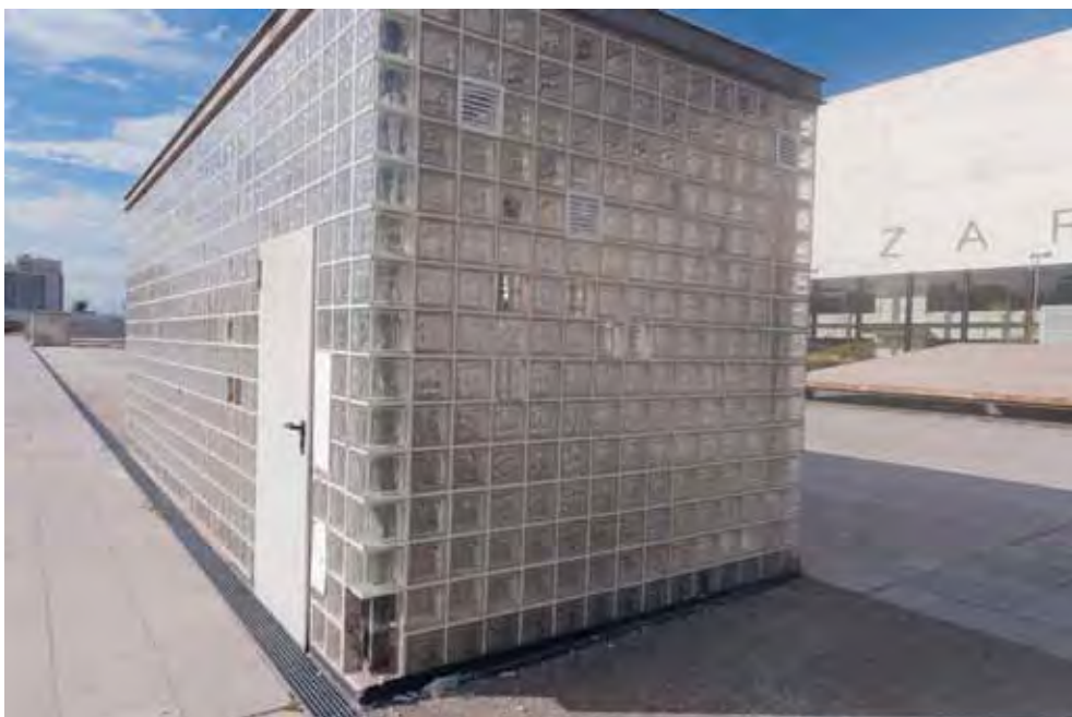
Figura 590. La piazza è stata progettata per valorizzare la facciata della Estacion de Delicias.
