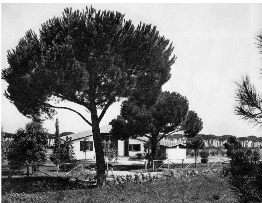
Fig. 43. Casa Allemandi, vista da sud, foto d'epoca, (aces).
