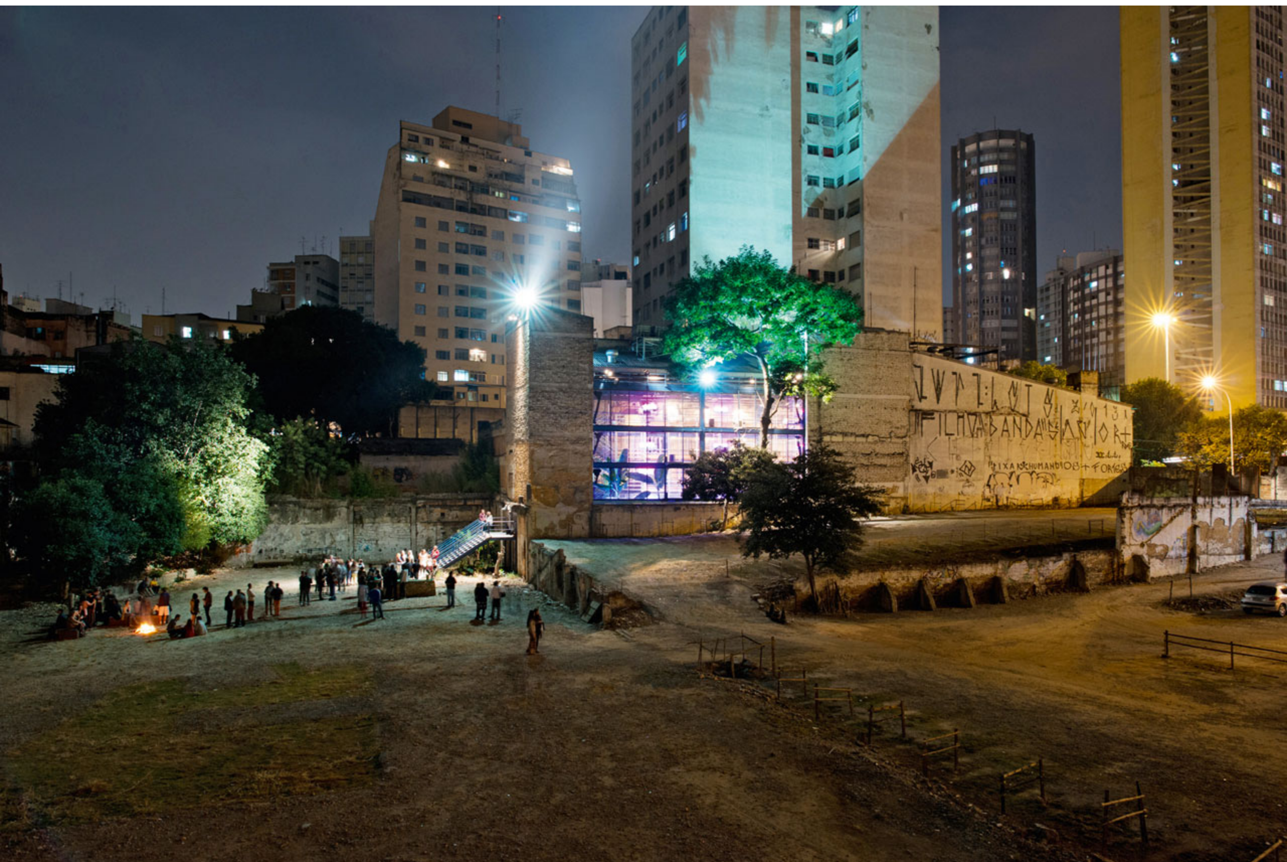
↑ Teatro Oficina, São Paulo, vista da ovest, 1984-1989 © Photo Markus Lanz, 2014
