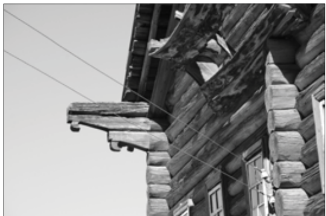
Molto spesso la porzione in aggetto veniva trattata artigianalmente eseguendo ad ascia dei profili particolari decorativi per la facciata.
