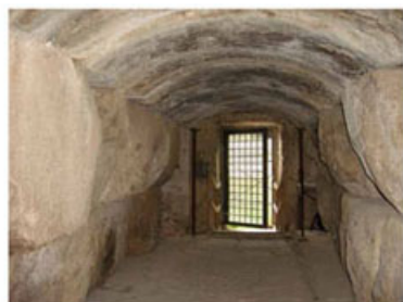
Fig. 3 Pianta piano terra; sono ben riconoscibili le imponenti masse, costituite in parte da conci ciclopici e in parte da calcestruzzo, dei resti del sepolcro romano dall'aggiunta del secondo decennio del Settecento dell'Osteria Nuova; il piccolo edificio a nord è una chiesa settecentesca, quello a sud est un annesso
