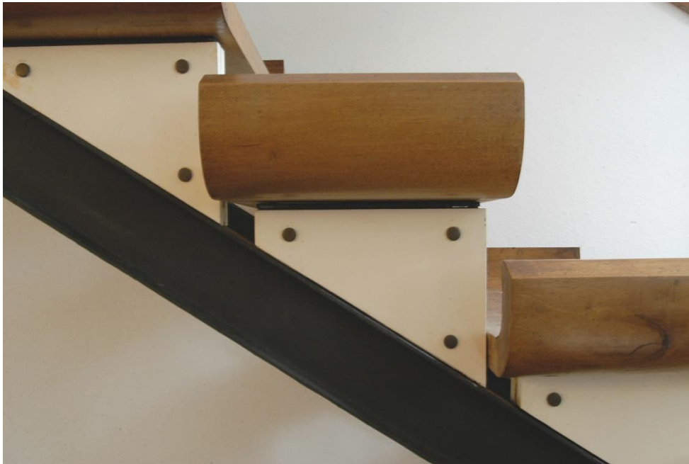
Fig. 34. Casa Bartolini, dettaglio della scala, stato attuale (flag).
