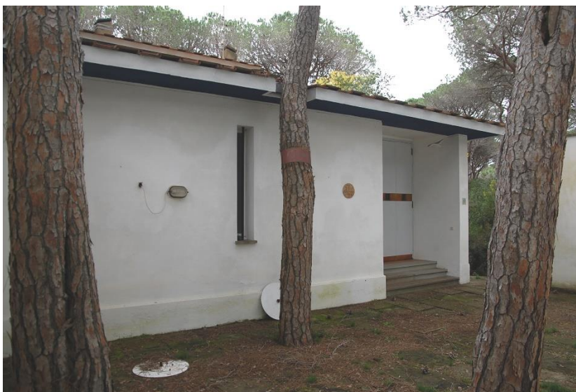
Fig. 10. Casa Bartolini, vista dell'ingresso principale dall'interno della corte, stato attuale (flag).
