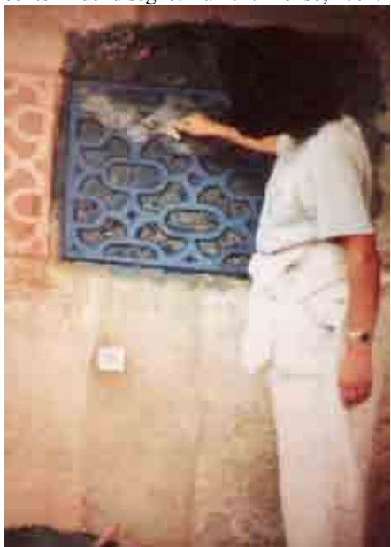
Fig. 25 - Esgrafiado embutido : processo di riempimento dei vuoti con intonaco di altro colore. Da R.R. Alonso, 2001.
