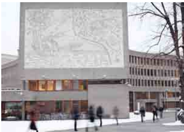
Fig. 29 - Naturbetong applicato sul fronte del Central Government Buildings (Regjeringskvartalet), Oslo; la decorazione "The Fishermen" è stata realizzata da Carl Nesjar prendendo come riferimento un disegno di Pablo Picasso.
