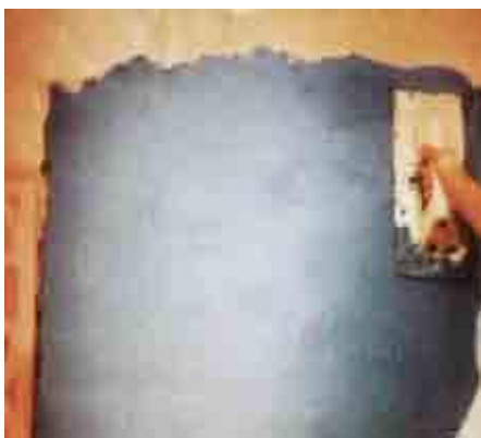
Fig. 23 - Esgrafiado embutido : stesura del primo strato colorato. Da R.R. Alonso, 2001.
