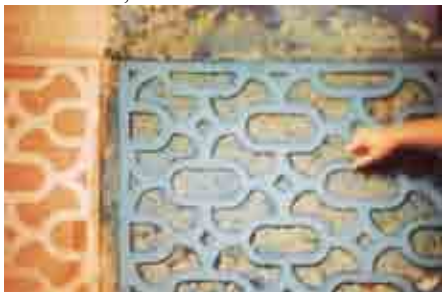
Fig. 24 - Esgrafiado embutido : processo di raschiatura seguendo i contorni del disegno. Da R.R. Alonso, 2001.
