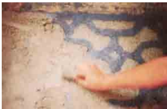
Fig. 26 - Esgrafiado embutido : raschiatura finale delle parti del secondo strato in eccesso. Da R.R. Alonso, 2001.
