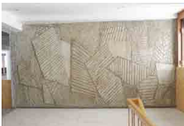
Fig. 28 - Esempio di una parete con sgraffito Naturbetong .
