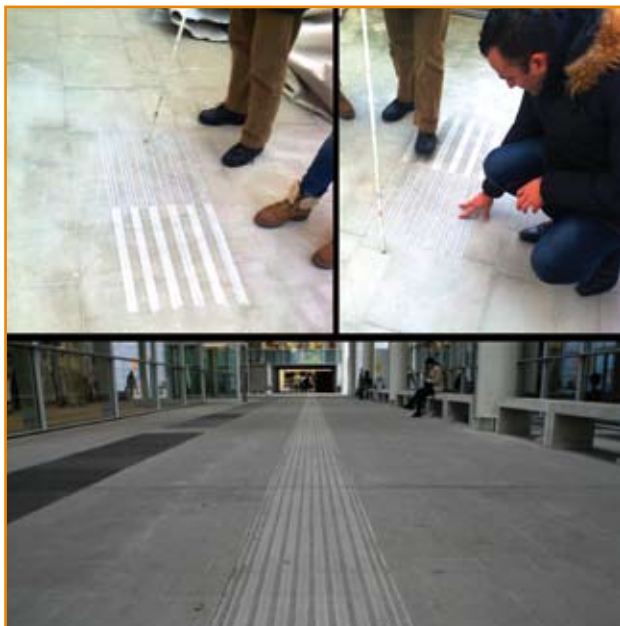
Piano per la realizzazioni delle pavimentazioni tattili presso l'edificio NIC. Test della soluzione progettuale e realizzazione finale
