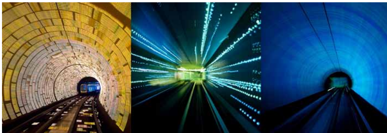
Shanghai, tre immagini del Sightseeing Bund riprese con tre diverse illuminazioni all'interno della galleria ferroviaria
