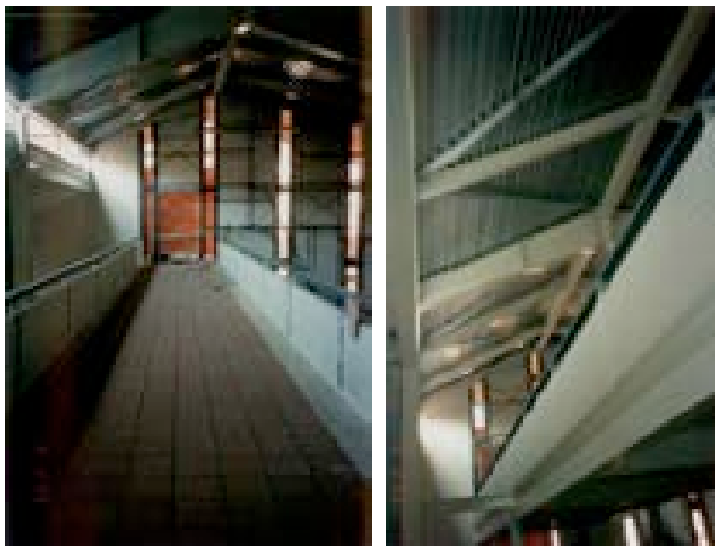
Figura 1643 – SX, il ballatoio superiore finito – (AABS-1998_02_13 - Foto Santa Rosa_01) Figura 1644 – DX, il ballatoio superiore finito – (AABS-1998_02_13 - Foto Santa Rosa_12)
