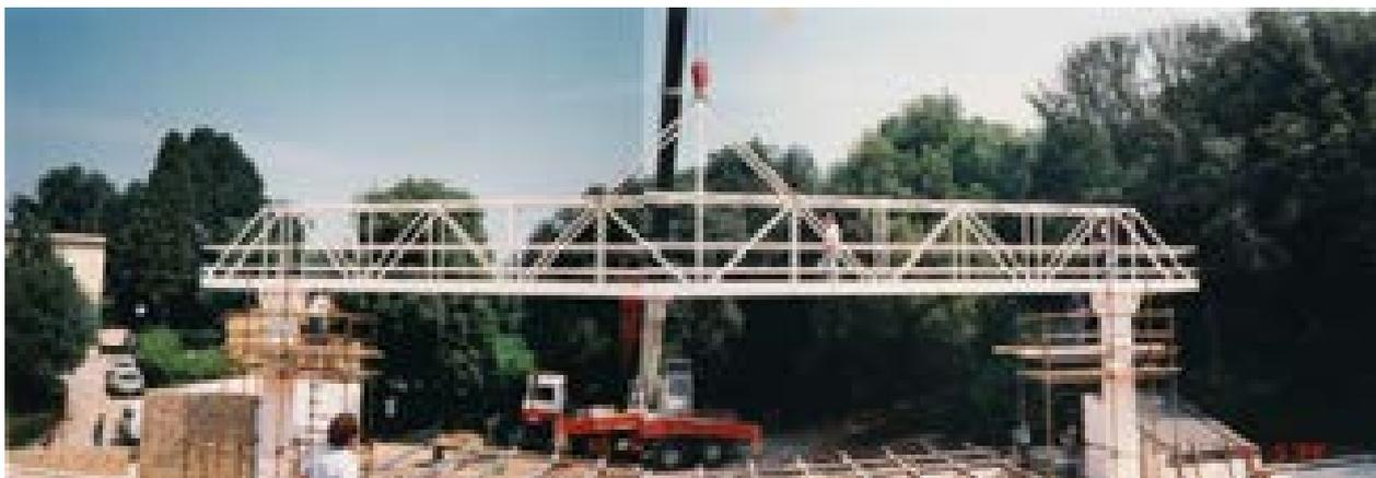
Figura 724 – DX, Fotografia SAL, il montaggio dell'americana metallica –19/06/1998 (AABS)
