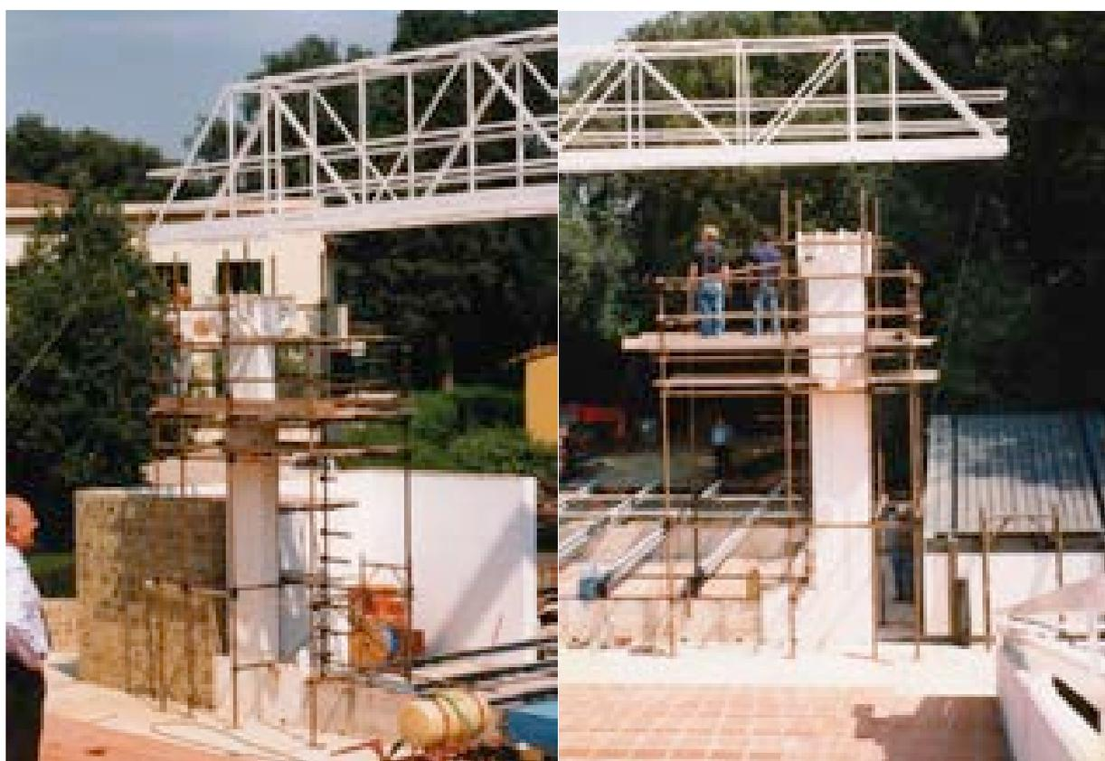
Figura 720 – SX, Fotografia SAL, il montaggio dell'americana metallica –19/06/1998 (AABS)
