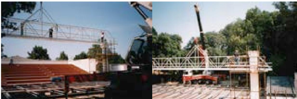
Figura 718 – SX, Fotografia SAL, il montaggio dell'americana metallica –19/06/1998 (AABS)
