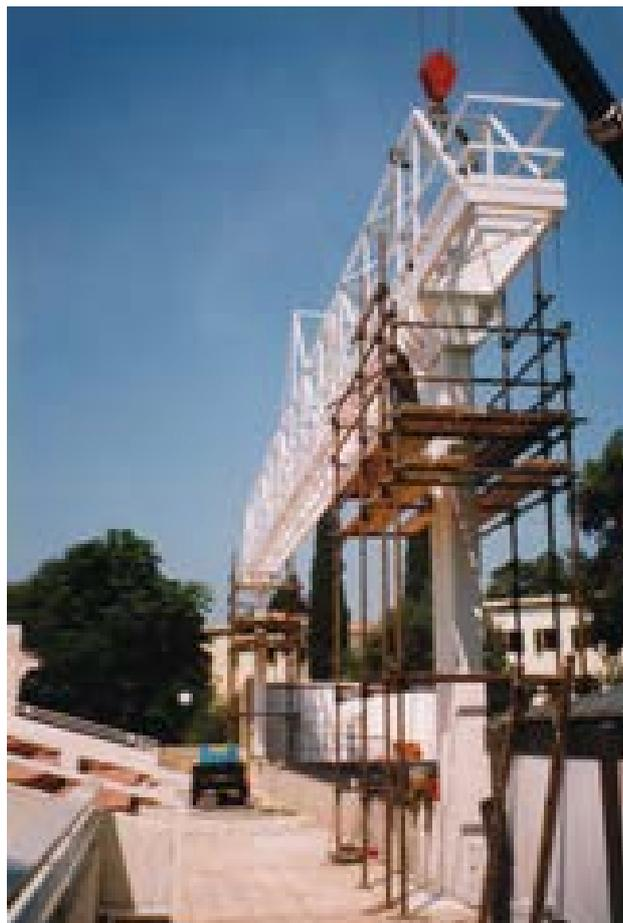
Figura 722 – SX, Fotografia SAL, il montaggio dell'americana metallica –19/06/1998 (AABS)
