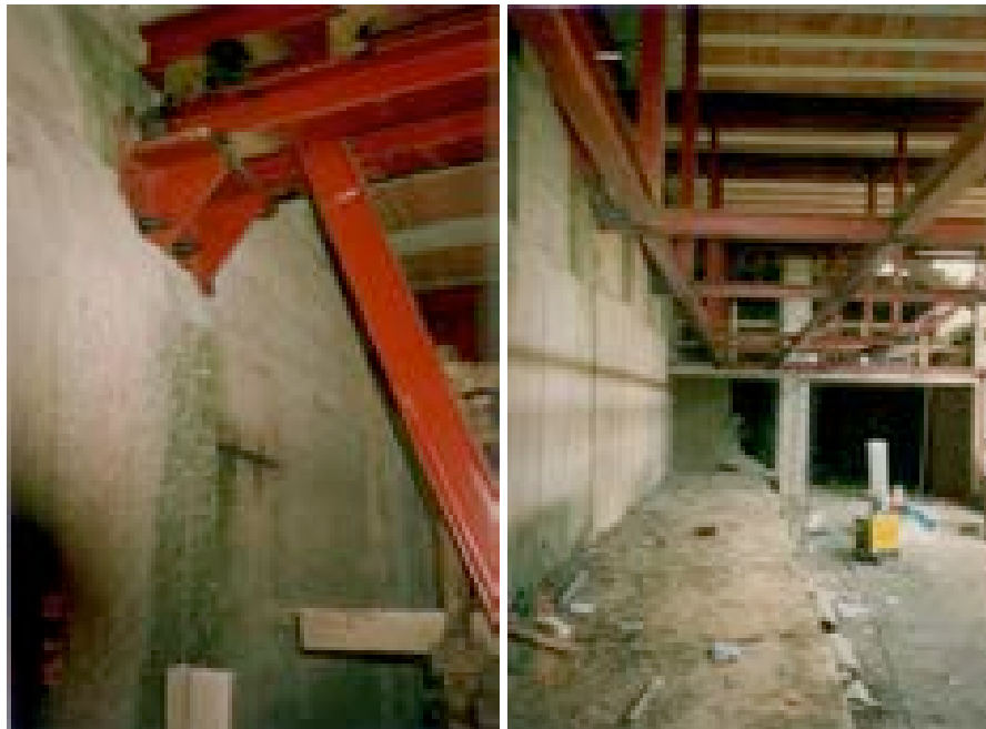
Figura 1075 – SX, L'attacco della passerella – SAL Giugno 1992 (AABS-1992_06_30 Valdimontone_03) Figura 1076 – La passerella – SAL Giugno 1992 (AABS-1992_06_30 Valdimontone_04)
