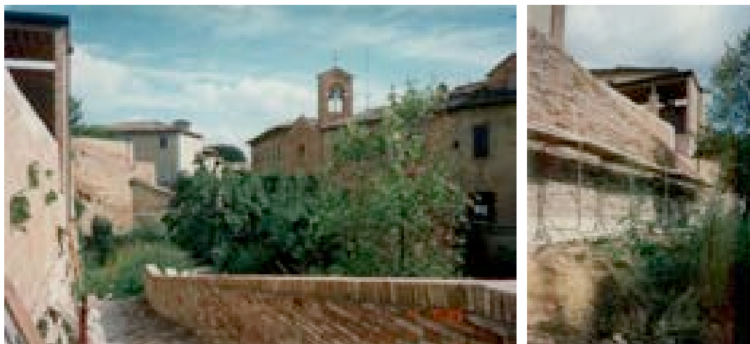
Figura 1113 – SX, il parapetto della rampa esterna – SAL 1995 (AABS-1995 Valdimontone_119) Figura 1114 – DX, il rivestimento della rampa esterna – SAL 1995 (AABS-1995 Valdimontone_126)
