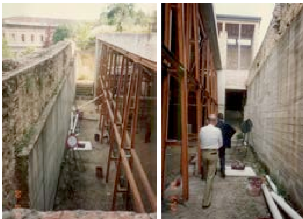
Figura 1079 – SX, il cavalletto metallico – SAL Giugno 1992 (AABS-1992_06_30 Valdimontone_11) Figura 1080 – DX, il cavalletto metallico – SAL Giugno 1992 (AABS-1992_06_30 Valdimontone_12)
