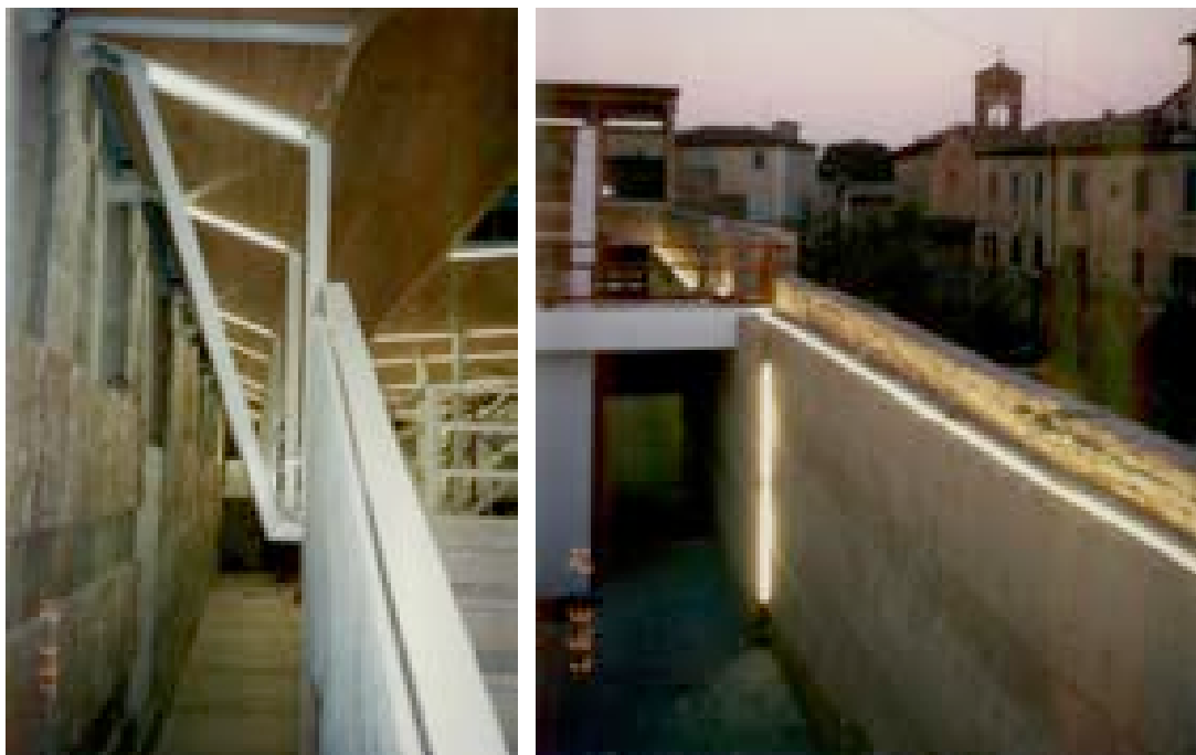
Figura 1144 – SX, l'illuminazione interna – SAL 1997 (AABS-1997 Valdimontone_81) Figura 1145 – DX, l'illuminazione esterna – SAL 1997 (AABS-1997 Valdimontone_73)
