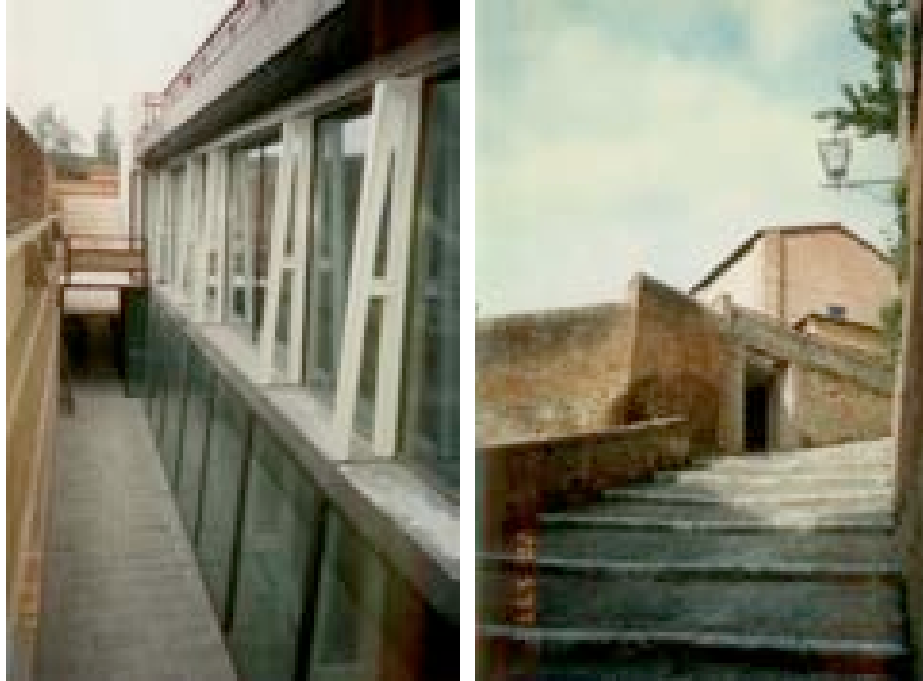
Figura 1148 – DX, l'esterno della sala delle vittorie – SAL 1997 (AABS-1997 Valdimontone_98) Figura 1149 – SX, la porta di ingresso nel muro esistente – SAL 1997 (AABS-1997 Valdimontone_109)
