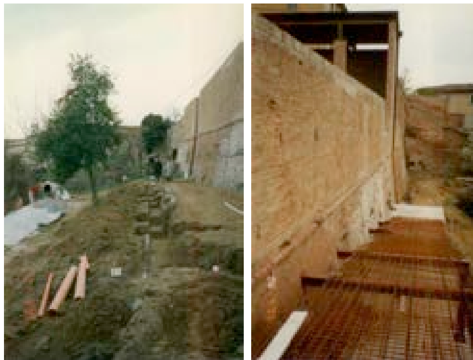
Figura 1109 – DX, le fondazioni della rampa esterna – SAL 1995 (AABS-1995 Valdimontone_06)
