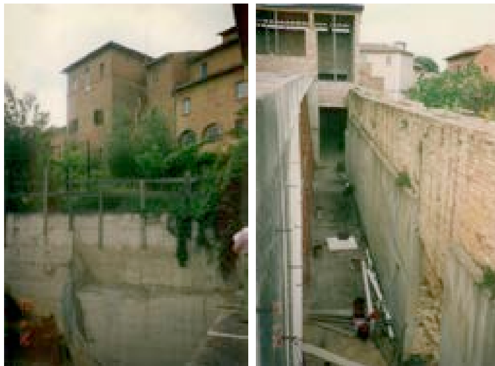
Figura 1077 – SX, Le strutture di contenimento in c.a. – SAL Giugno 1992 (AABS-1992_06_30 Valdimontone_11) Figura 1078 – DX, Le strutture di contenimento in c.a. – SAL Giugno 1992 (AABS-1992_06_30 Valdimontone_12)
