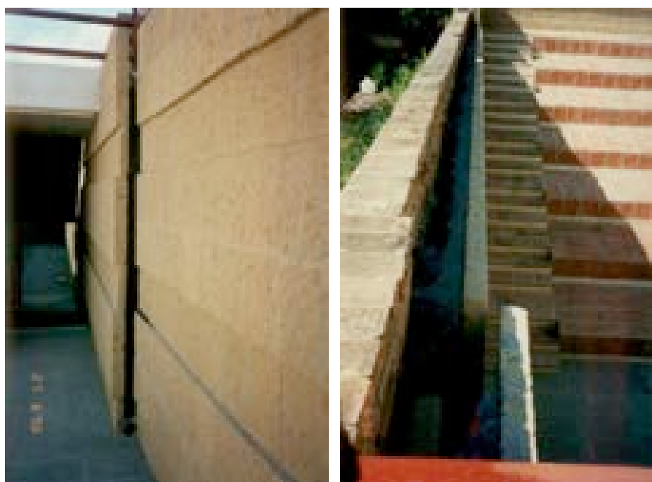
Figura 1130 – SX, il rivestimento esterno in tufo – SAL 1996 (AABS-1996 Valdimontone_35)
