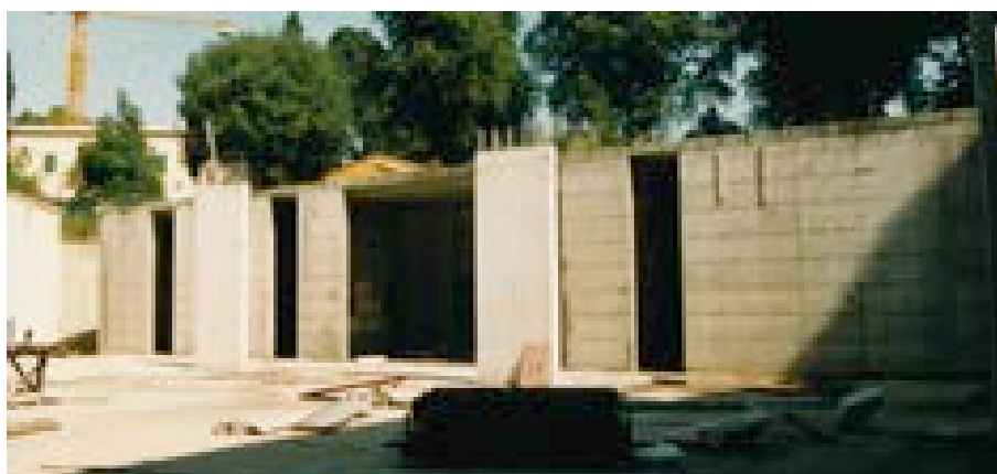
Figura 469 – SX, Fotografie del SAL, i pilastri in c.a. portante la reticolare – 07/1993
