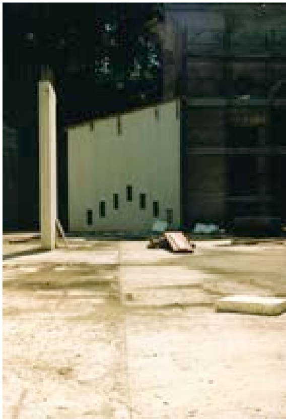
Figura 465 – SX, Fotografie del SAL, setto in c.a. forato per impianto areazione – 07/1993 Figura 466 – DX, Fotografie del SAL, Scala ovest di accesso al palco superiore – 07/1993
