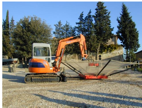
Fig. 4.108 Il cantiere di raccolta realizzato dall'Università di Firenze
