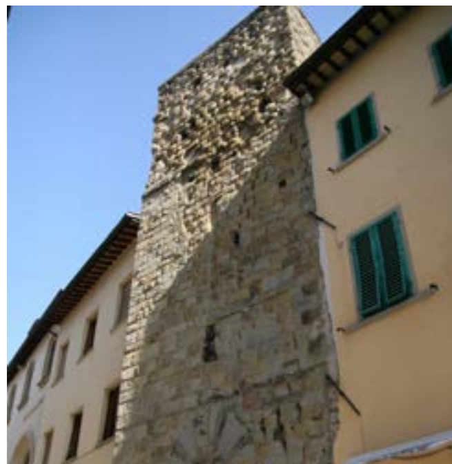
70/ Torre dei Gherardi Nord, via XX Settembre. Da notare l'allineamento l'angolo assunto dalle torri rispetto all'edificato adiacente
