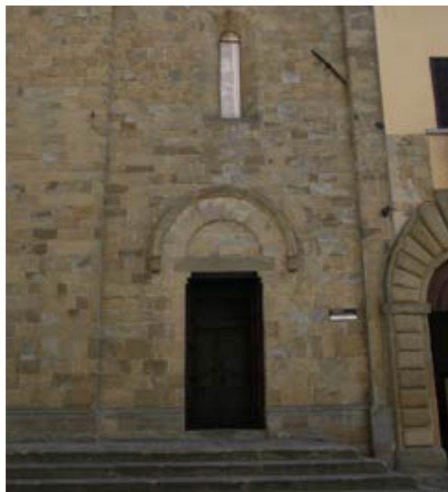
46/ Fotografia della facciata. Da notare il risalto della porzione centrale
