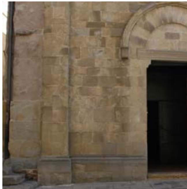
45/ Particolare della parasta di sinistra della facciata del Duomo di Sansepolcro
