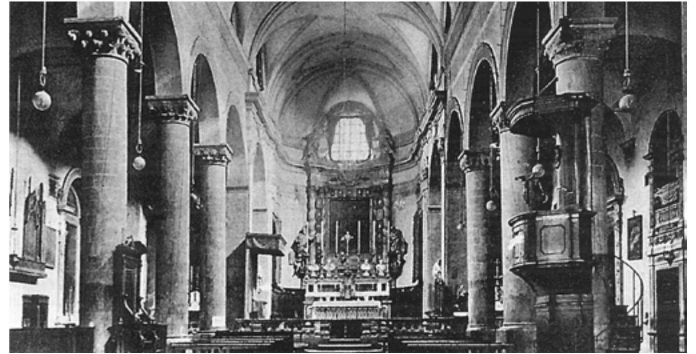
29/ Fotografia del Duomo di Sansepolcro ante i lavori di restauro ad opera dell’Ing. Gabrielli (terminati nel 1943)
