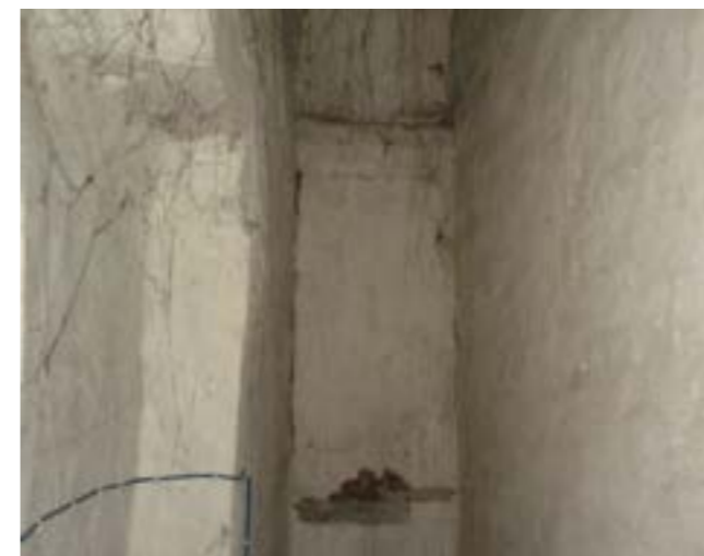
67/ Fotografia dell'intercapedine all'altezza della porta tamponata
