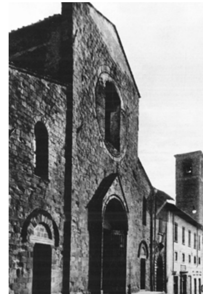
25/ Fotografia della facciata ante i lavori di ripristino del rosone. Da notare la perfetta visibilità del cerchio del rosone nel paramento murario della facciata (Tratta da FORNASARI 2012)
