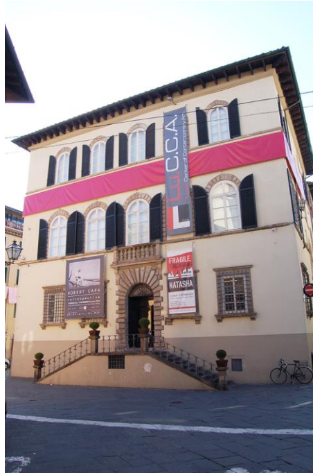
Palazzo Boccella alla Fratta a Lucca
