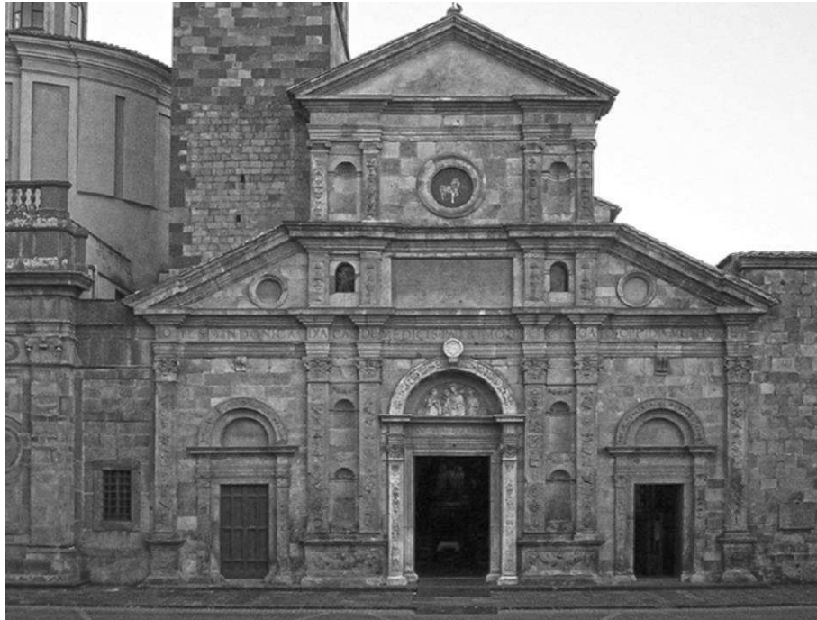
La facciata di Santa Cristina a Bolsena
