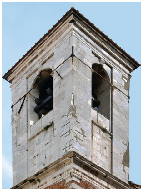
La cella campanaria del campanile di San Paolino a Lucca
