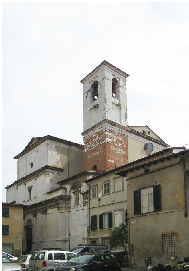
Il campanile e la porzione tergale di San Paolino a Lucca visti dalla piazza di San Piero in Vincoli
