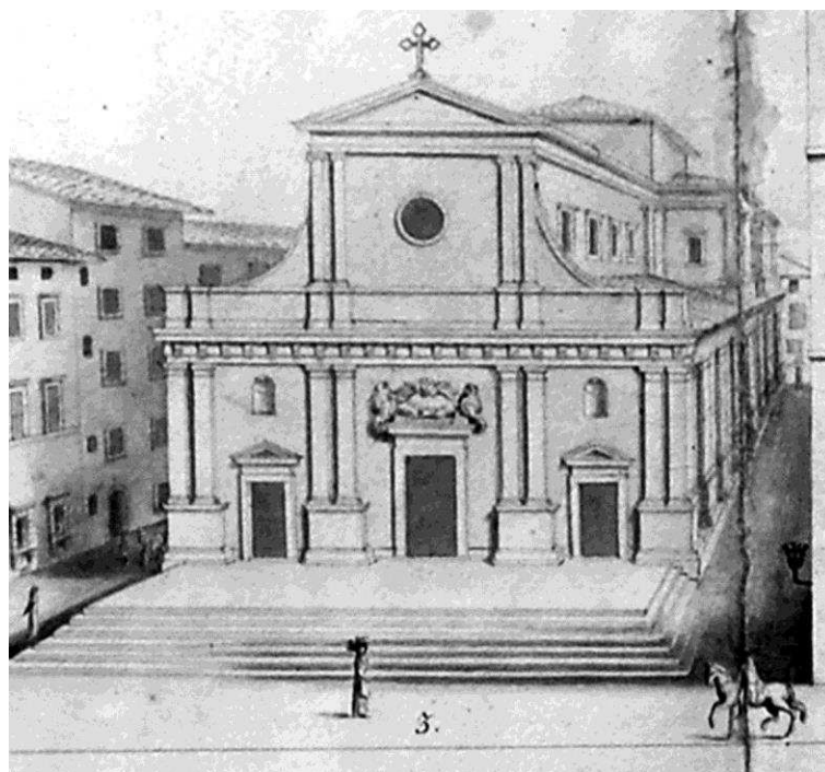
Lorenzo Nottolini, la chiesa di San Pier Maggiore alla vigilia della demolizione, ASL, Fondo Nottolini, 1949, particolare
