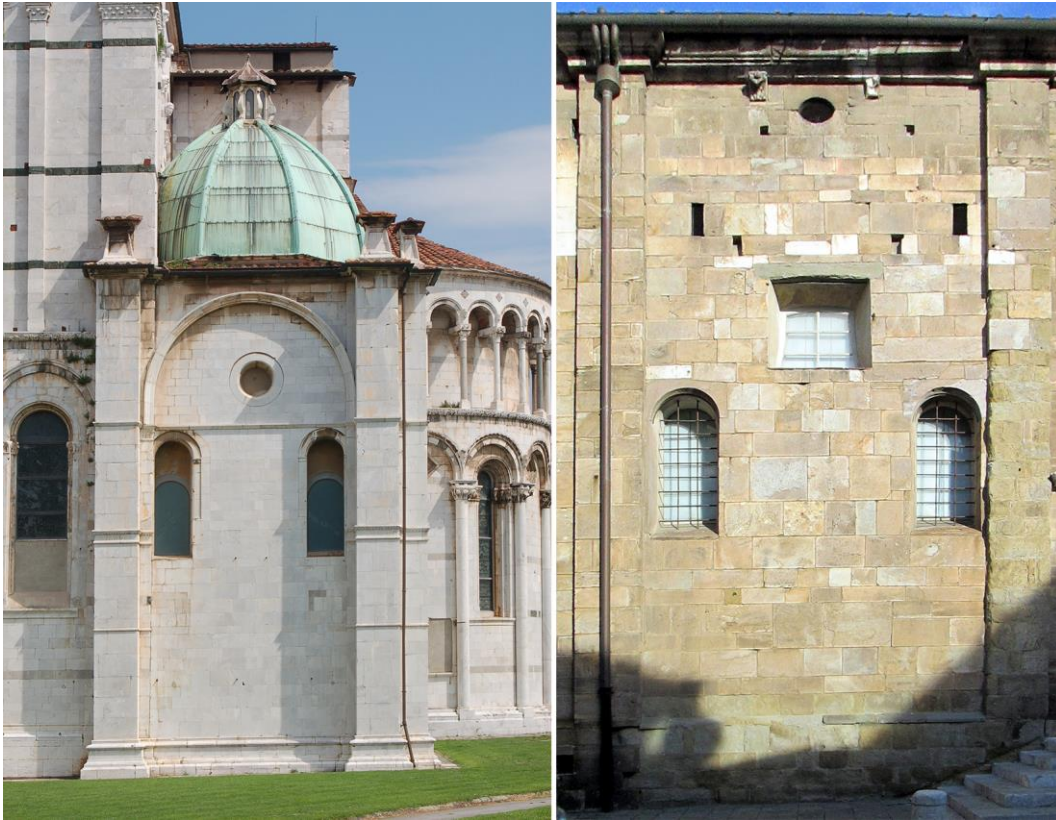
A sin., la cappella del Santissimo Sacramento, prospetto laterale, a des., la cappella di Sant'Agostino presso San Frediano a Lucca, prospetto esterno
