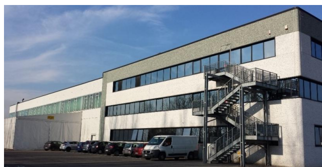
Figura 4. Vista lotto 4 con scala antincendio e lotto 3 con struttura leggera indipendente (prospetto sud-ovest).
