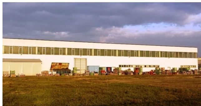
Figura 3. Vista lotto 1 (prospetto sud-est).
