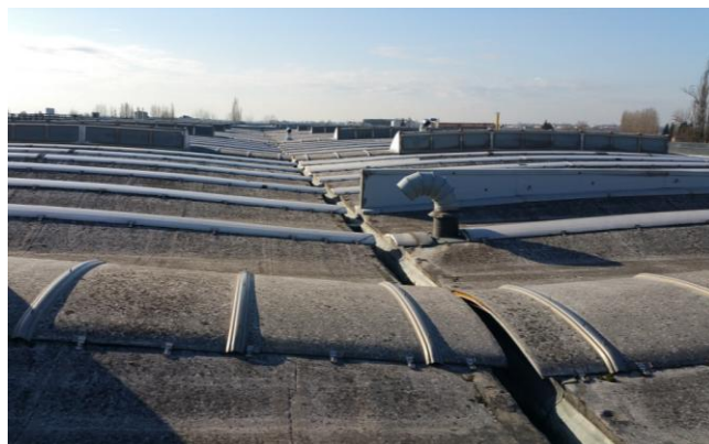
Figura 8. Vista della copertura - zona industriale.
