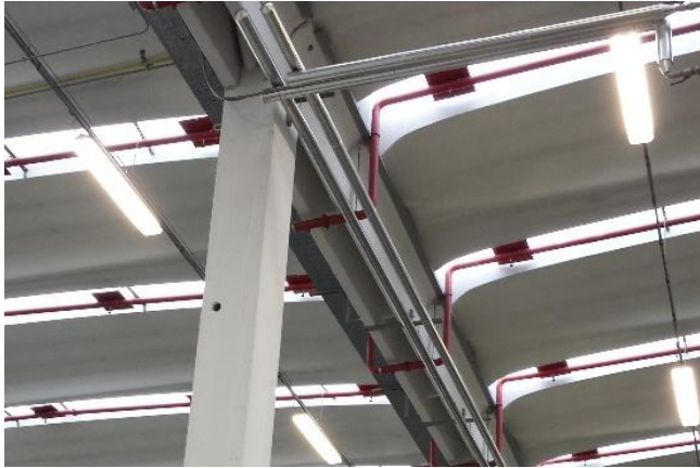
Figura 5. Particolare copertura lotti 1, 2 e 3.
