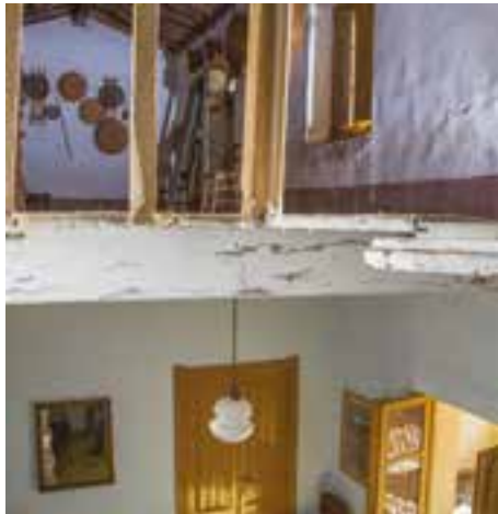
Fig. 5 Suspended floor in Samassi, Sardinia, Italy (photo: Associazione Nazionale Città della Terra Cruda).
