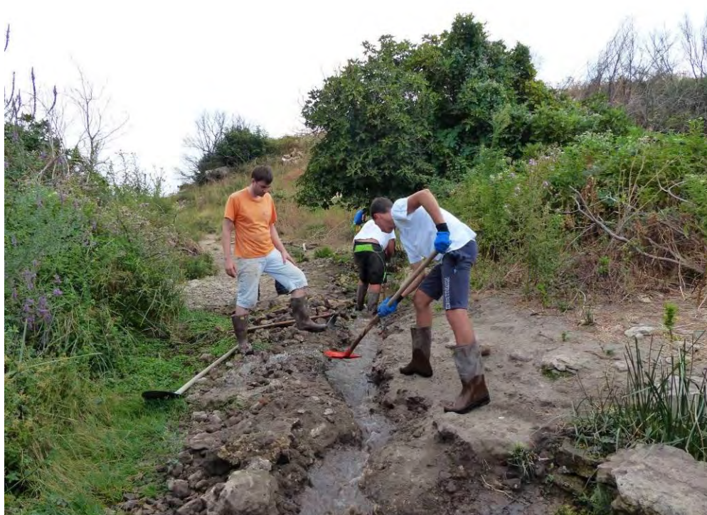
Fig. 33.2: Lavori preliminari di ripristino del tragitto dell'acqua che fuoriesce da un'antica fonte in un terreno confiscato presso Isola Capo Rizzuto (Crotone). Gruppo di volontari, all'opera, agosto 2014. Foto di C. Scoccianti
