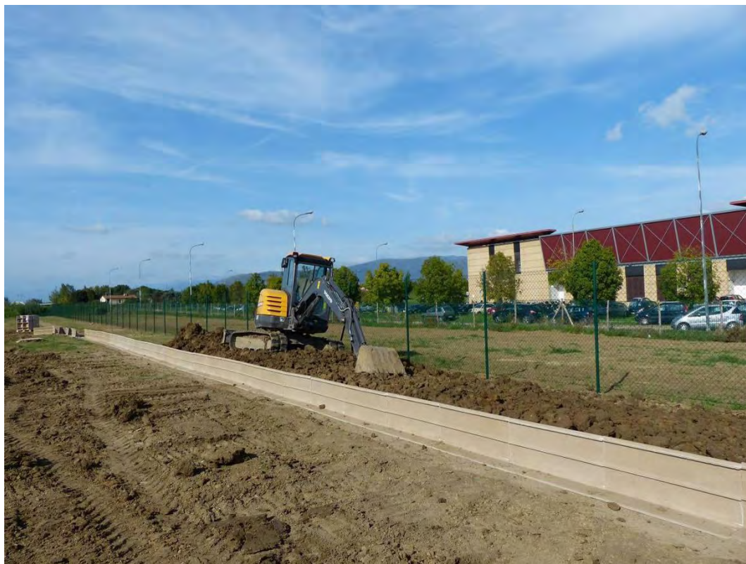
Fig. 30.4 Lavori conclusivi dell'ingrandimento dell'Oasi WWF Val di Rose. Posa in opera sul confine nord dell'area di una barriera antiattraversamento per evitare che gli Anfibi sconfinino verso i nuovi edifici dell'Università (ottobre 2013). Foto di C. Scoccianti
