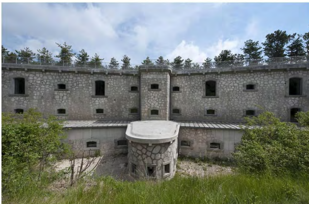
Forte Santa Viola, dopo l'intervento di restauro.
