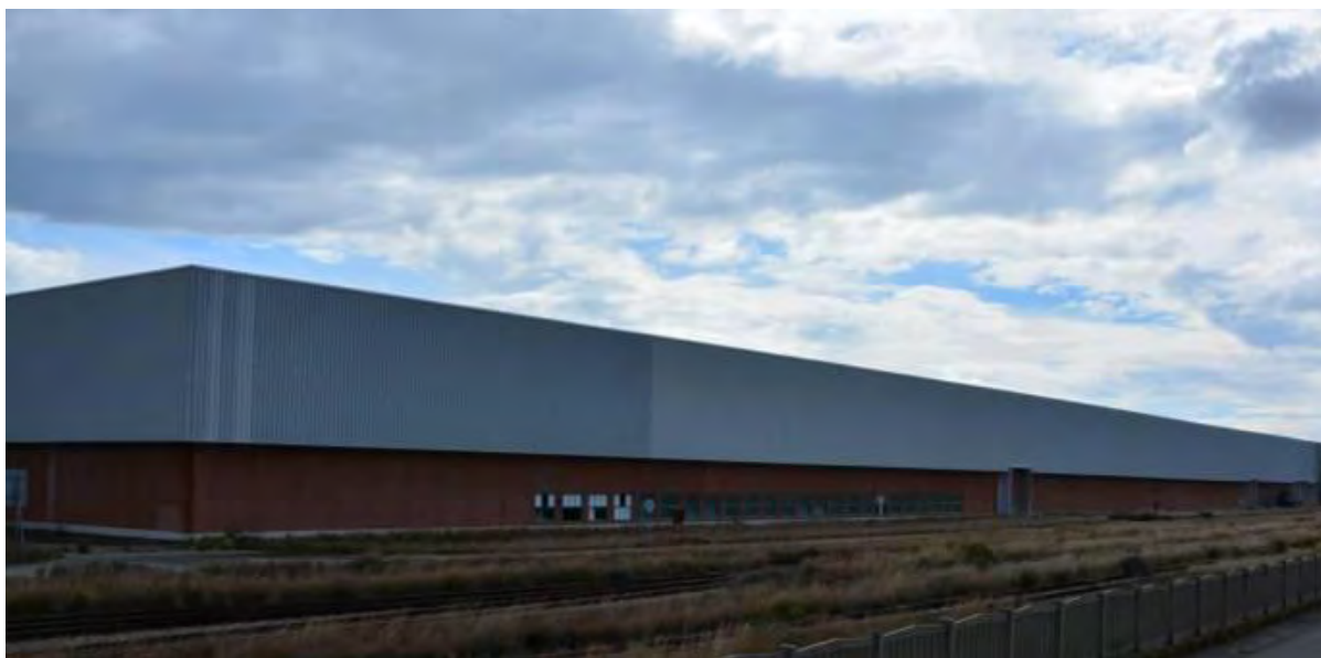
Fig. 19.1. Le Officine Grandi Riparazioni delle FS: ettari di capannoni abbandonati da più di un decennio
