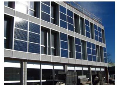
03 | La sede (in fase di ultimazione) del polo Tecnologico di Lucca in cui sarà ospitato il «centro di divulgazione» Abitare Mediterraneo
