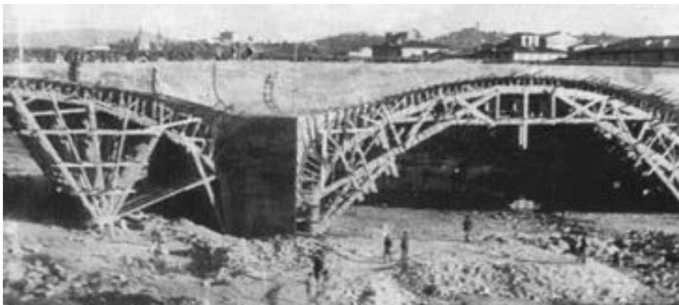
Il ponte della Vittoria in costruzione. Gennaio 1946, Archivio Gamberini, Firenze
