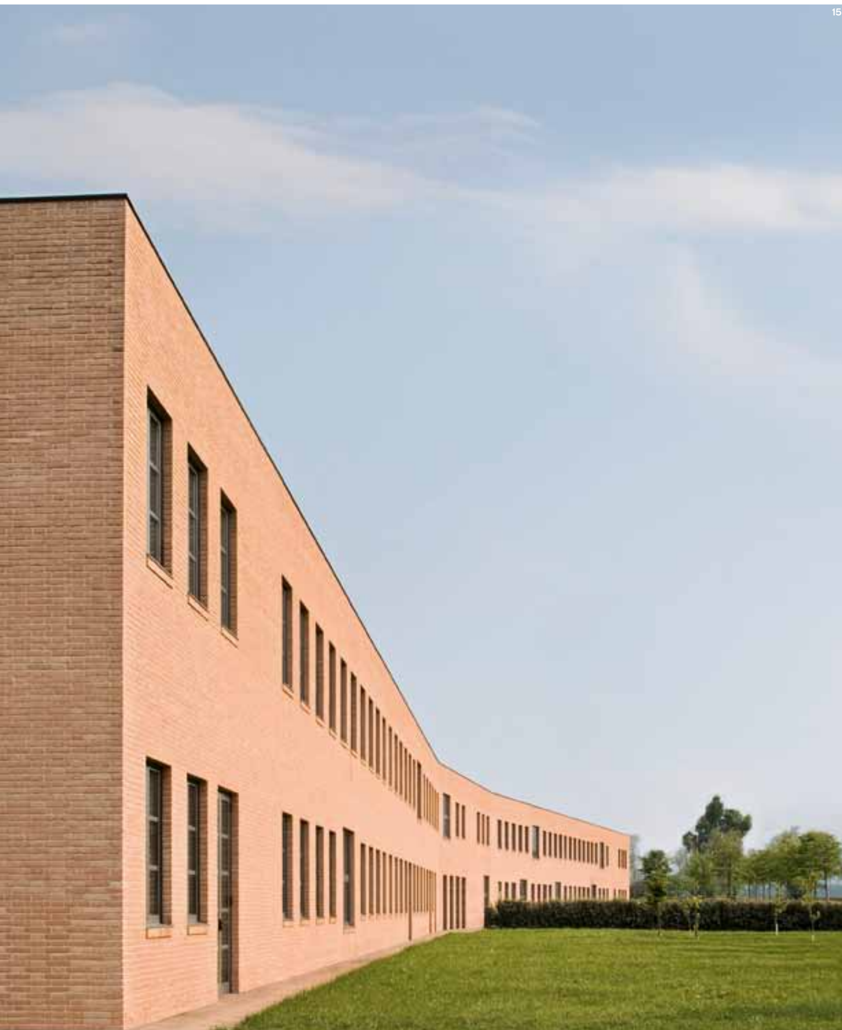
15 -vista del fronte principale con l'ingresso al complesso scolastico -view of the main facade with the entrance to the school complex
