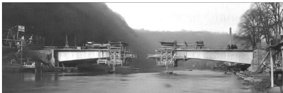
Fig. 3 - Ponte di Balduinstein ( L_{tot} 62.0 m) Fase di costruzione dei conci tramite casseri mobili. Trattandosi di un impalcato a campata unica le estremità laterali sono dotate di contrappeso per sostenere la costruzione a sbalzo (Troyano Fernández, 2006).
