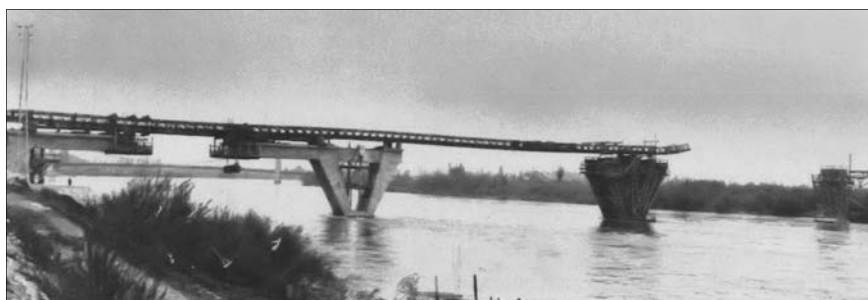
Fig. 16 - ( L_{\text{tot}} 300.0\text{ m} , L_{\text{max}} 56.0\text{ m} ) (F,1955). L'impalcato, realizzato con carro di varo superiore conquista il record di lunghezza complessiva per viadotti ferroviari. (Wittfoht, 1984)
