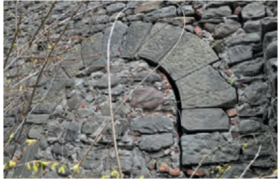
Fig. 13 - Particolare di un arco sul lato occidentale dell'ospedale
