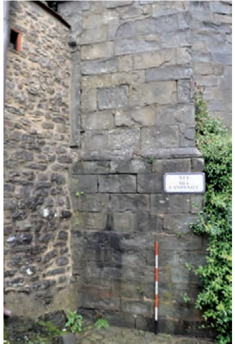
Fig. 2 - Lato meridionale della chiesa di San Matteo
