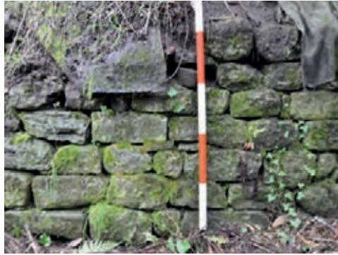
Fig. 7 - Particolare della tecnica costruttiva della cinta
