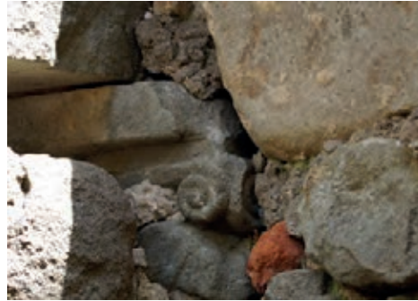
Fig. 12 - Voluta della mensola dell'accesso (B) semi-incastonata nella successiva muratura
