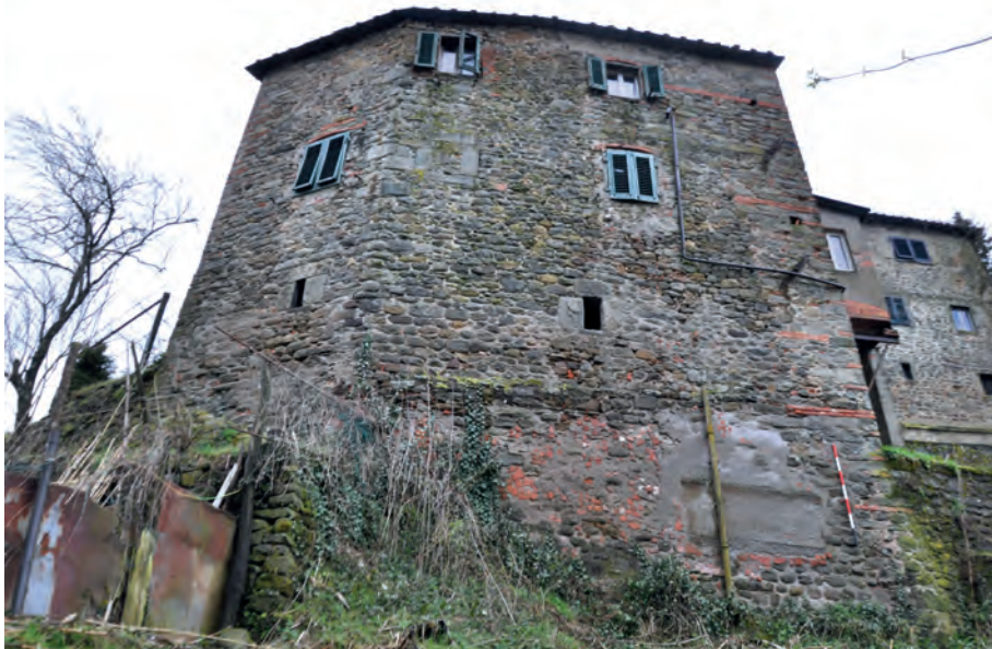
Fig. 5 - Edificio medievale sul lato orientale di Pietrabuona
