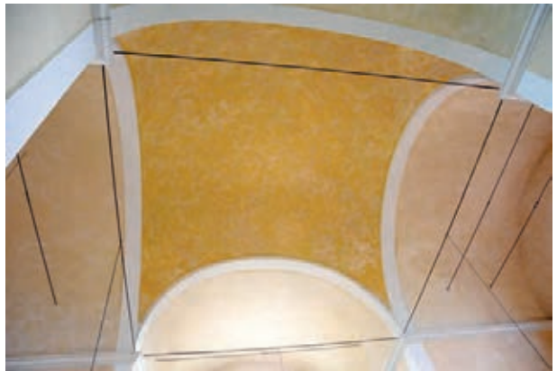
Fig. 8 - I bracci laterali dell'edificio, coperti con volte a botte e colorati nei toni del rosa, e l'area centrale voltata a vela e dipinta in giallo (foto di Giovanni Anzani)
