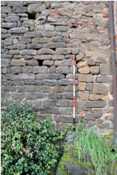
Fig. 6 - Particolare del lato orientale del palazzo comunale trecentesco. Si noti a destra il preesistente arco in arenaria
