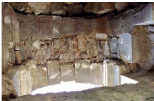
Fig. 7 - Muratura a sacco che caratterizza l'intera fabbrica lucchese
