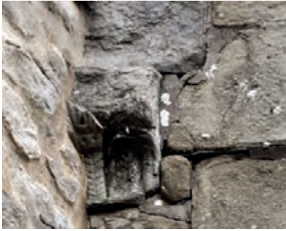
Fig. 11 - Mensola a sostegno dell'architrave dell'accesso (B)
