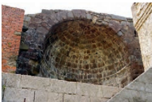
Fig. 8 - Abside a ferro di cavallo della chiesa di San Matteo
