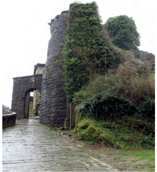
Fig. 2 - Abside e fianco Nord-Ovest della Rocca
