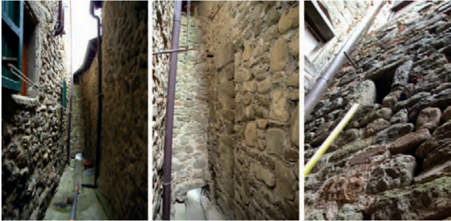
Fig. 3 - Il "chiasso" che separa i muri tergalì agli edifici che si affacciano su via del Campanile e via della Ruga. Lo stipite presente nell'immagine centrale fa parte della muratura appartenente al fabbricato che prospetta su via della Ruga, mentre la bucatura nell'immagine a destra è inserita nel paramento della costruzione che si apre su via del Campanile
