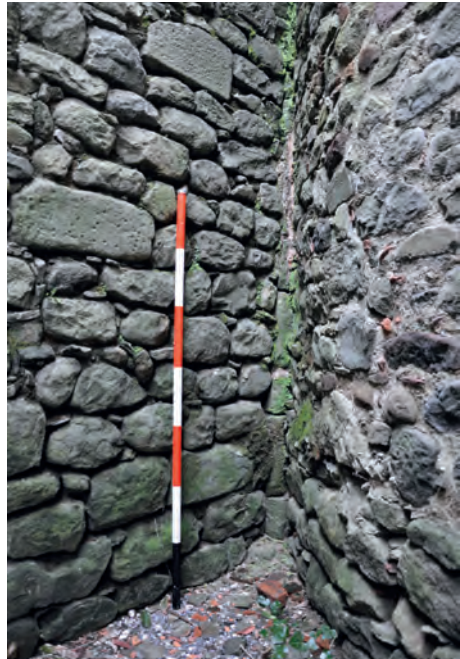
Fig. 4 - Sulla sinistra la parete settentrionale dell'ospedale quattrocentesco
