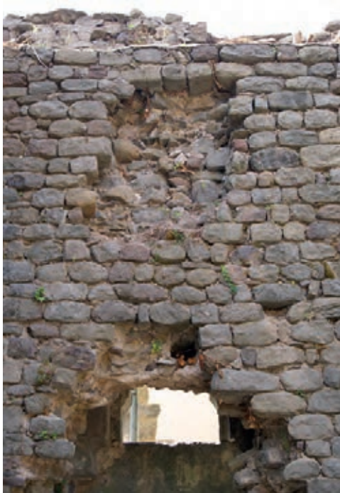
Fig. 8 - Particolare della torre costruita all'interno della chiesa di San Matteo
