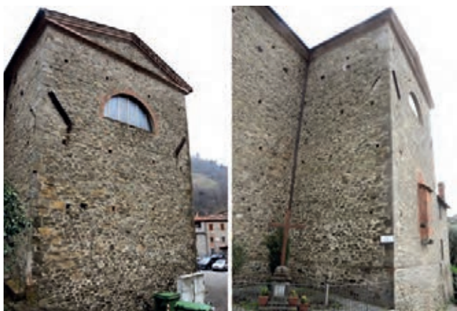
Fig. 6 - Prospetti Est ed Ovest della chiesa (foto di Giovanni Anzani)
