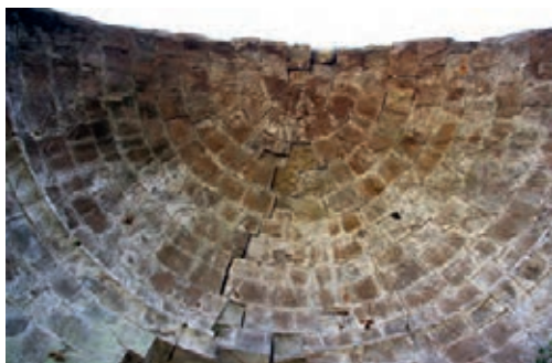
Fig. 9 - Catino absidale realizzato con buona cura stereotomica
