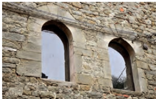
Fig. 3 - Aperture del primo livello coronate da archi ogivali crescenti
