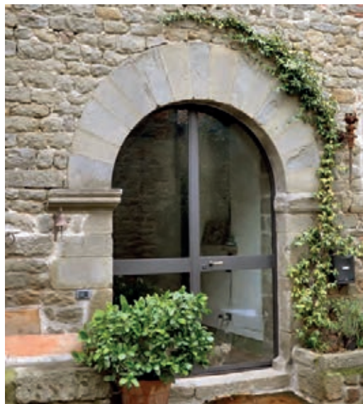
Fig. 2 - Particolare della mensola modanata dell'accesso principale
