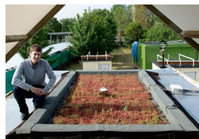
Fig.II.11. Test su un componente di facciata (parete opaca) e su un sistema di copertura (tetto verde).
