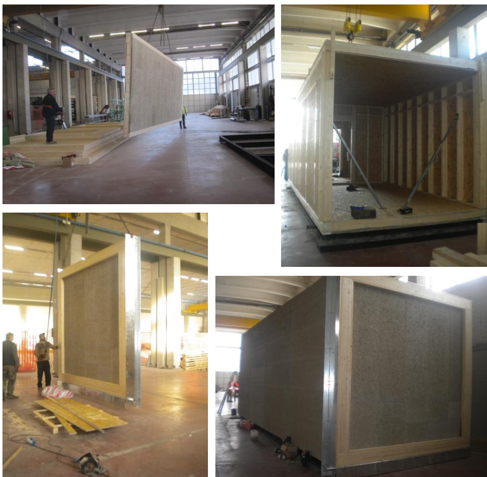
Fig.II.23.. Immagini della costruzione e dell'assemblaggio in stabilimento della struttura della Test Cell realizzata mediante tecnologie a secco in legno del tipo Platform Frame.
