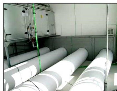
Fig.II.7. Vista della Plant Room destinata agli impianti
