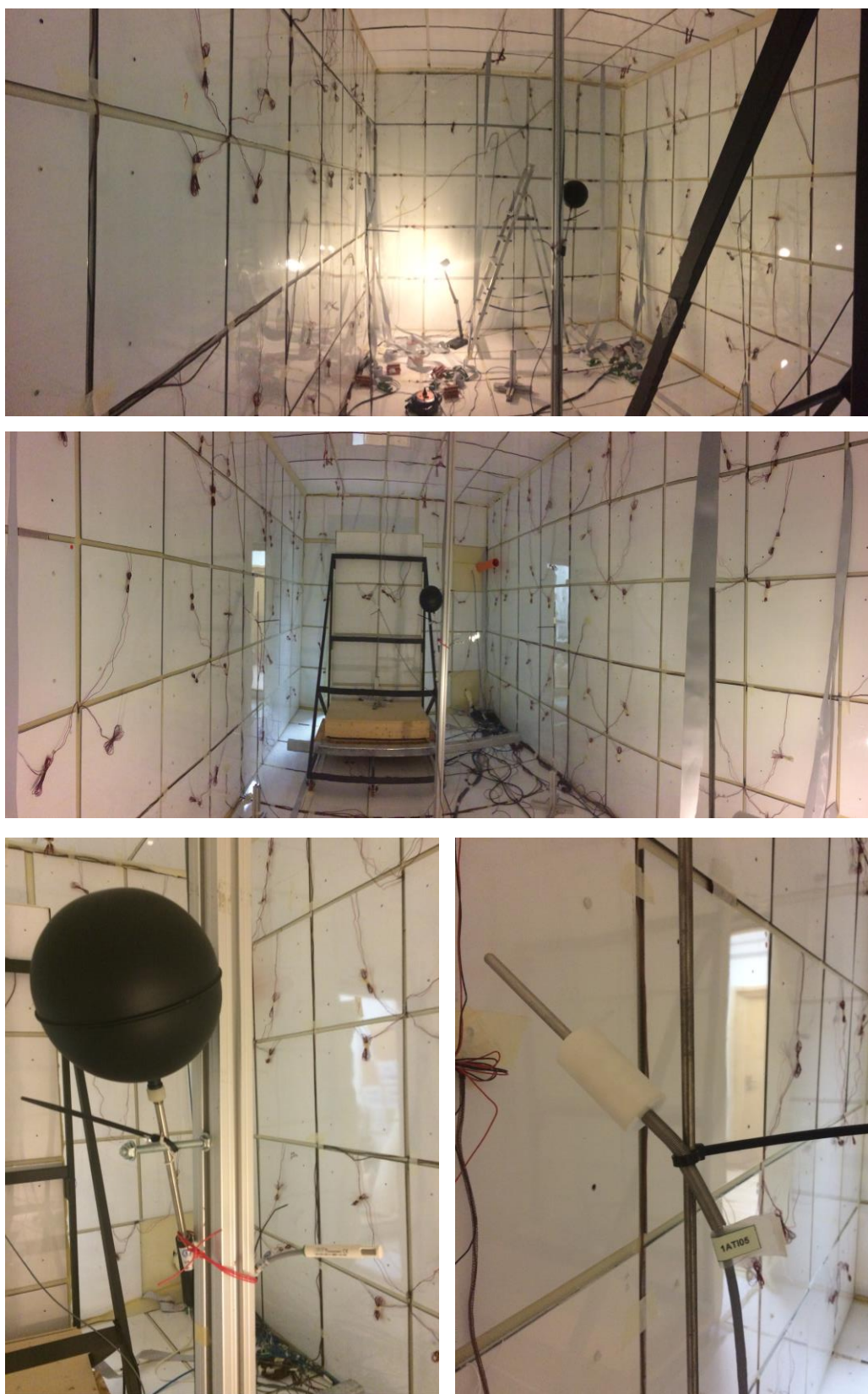
Fig.III. 13.Strumentazione e sistema HFS installato all'interno della Test Room. Globotermometro per la misura della temperatura radiante interna e trasmettitore miniaturizzato di temperatura e umidità relativa (in basso a sinistra); termoresistenza PT100 per la misura della temperatura dell'aria (in basso a destra)
