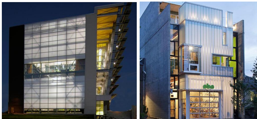
Fig.I.13. Applicazione del sistema Lumira aerogel in sistemi di involucro trasparente avanzati. École Nationale de Cirque, Montréal, Canada, Lapointe Magne e Associati (a sinistra). Building 115, Seattle WA, Graham Baba Architects (a destra). (Fonte: Techncal Glass Products)
