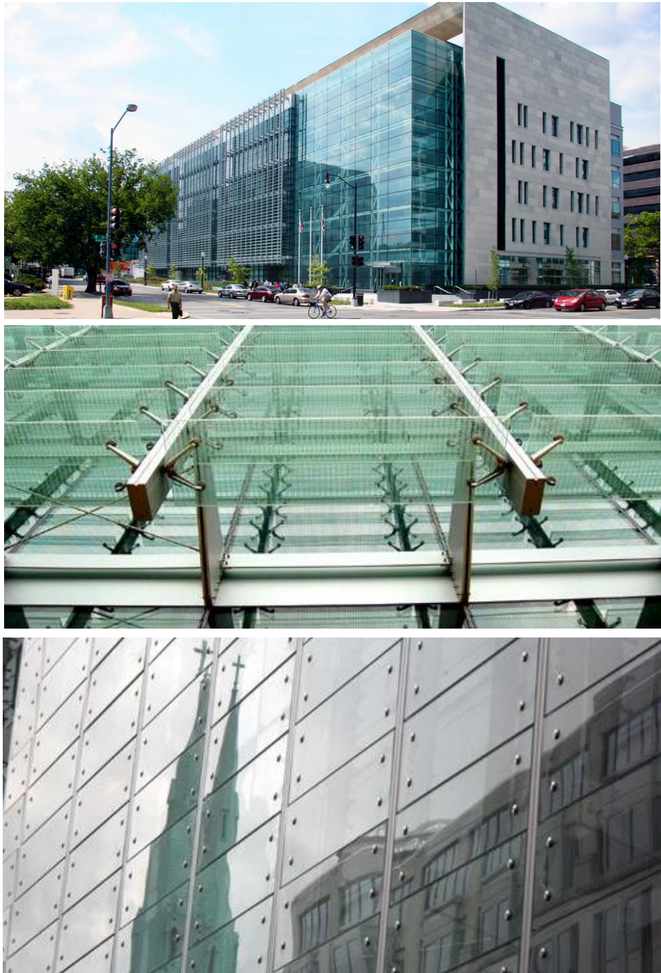
Fig.I. 10. Consolidated Forensics Lab, Washington DC, HOK, 2013. Certificazione LEED-NC Platinum. Il design innovativo dell'involucro architettonico è caratterizzato da una facciata in vetro dotata di un sistema di schermatura solare in lamelle di vetro il cui orientamento è controllato mediante una stazione meteorologica posta sul tetto. Al variare delle condizioni ambientali esterne, il sistema di controllo solare realizza la seconda pelle dell'edificio per garantire condizioni di comfort indoor nell'edificio. (Fonte: http://www.hok.com )
