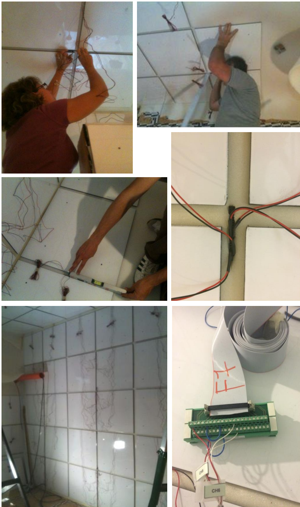
Fig.III. 12. Installazione e cablaggio del sistema Heat Flux Tiles all'interno della Test Room. Collegamento in serie mediante l'uso di flat cables e moduli di interfaccia per l'ottenimento dei segnali finali.
