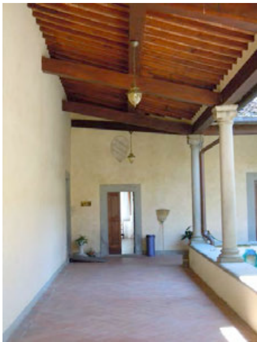
Fig. 216 Ingresso della sagrestia sormontato da uno stemma Mannelli, probabilmente già sul prospetto esterno del chiostro. (Foto dell'autore)
