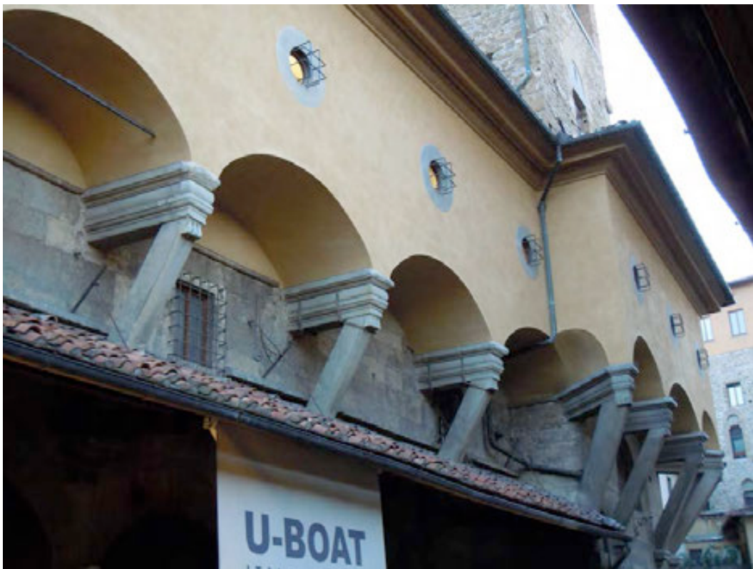
Fig. 50 Corridoio Vasariano nel tratto corrispondente all'abitazione dei Mannelli, particolare con le finestre del piano nobile fra i "beccatelli". (Foto dell'autore)
