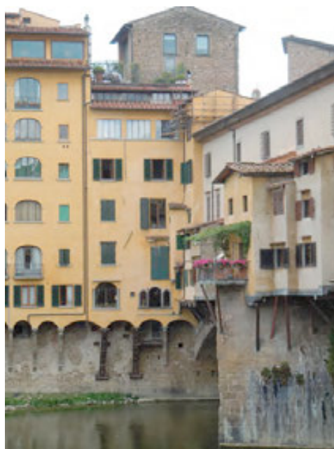
Fig. 47 Edificio postbellico costruito sull'area già occupata dall'antico Palazzo Mannelli. (Foto dell'autore)
