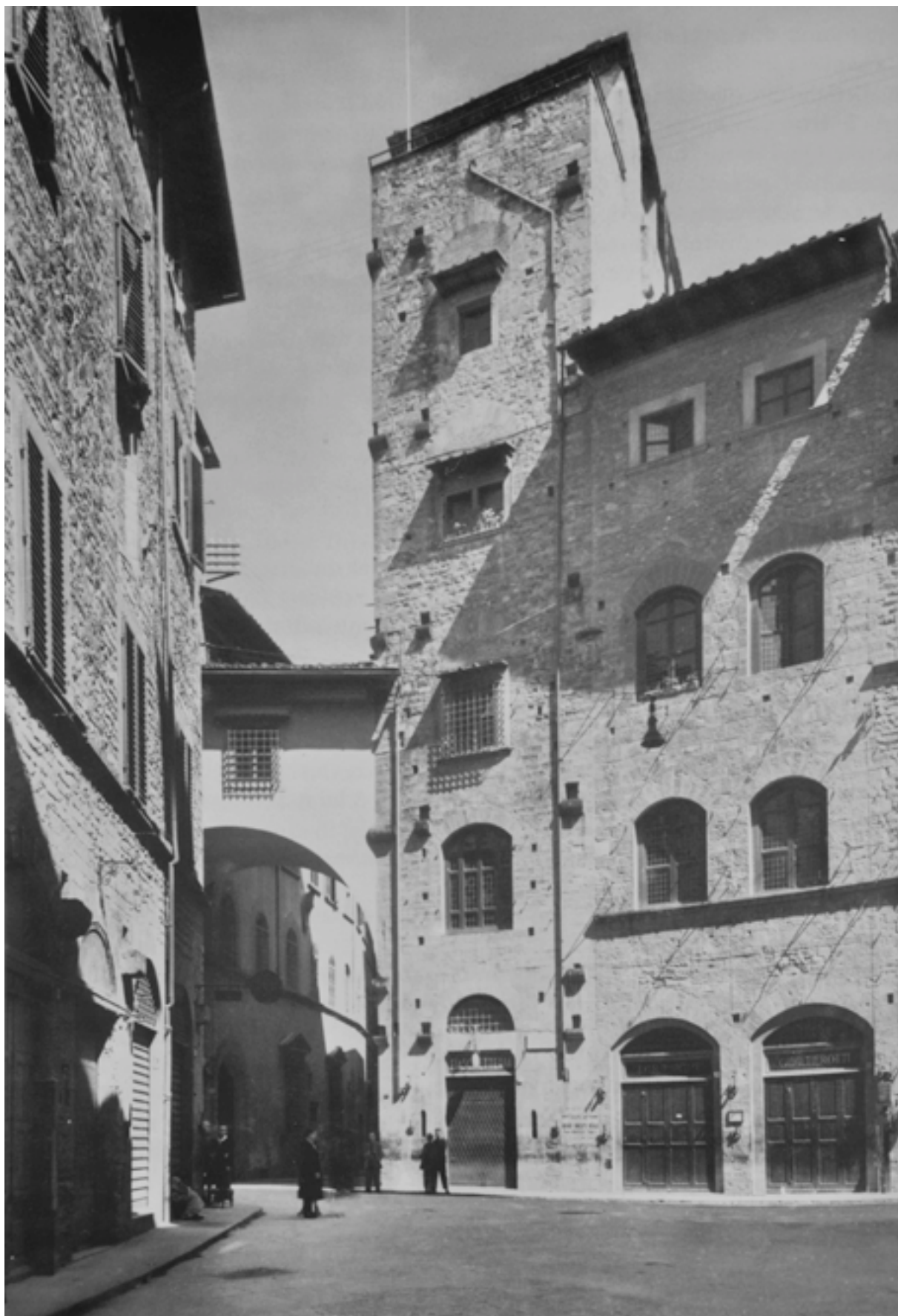
Fig. 26 Palazzo Mannelli, scorcio del prospetto su via de' Bardi ripreso dall'imbocco di Borgo San Jacopo, fine XIX secolo. (da: Gianluca Belli, Amedeo Belluzzi, Una notte d'estate del 1944. Le rovine della guerra e la ricostruzione a Firenze . Firenze: Polistampa, 2013)
