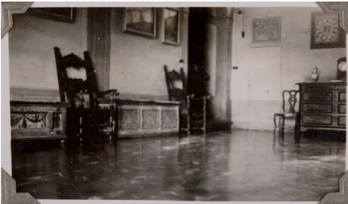
Fig. 179 Fibiiana (Montelupo Fiorentino), Camera di disimpegno del piano nobile della villa Mannelli poi Antinori, 1940 ca. (Foto in collezione privata)
