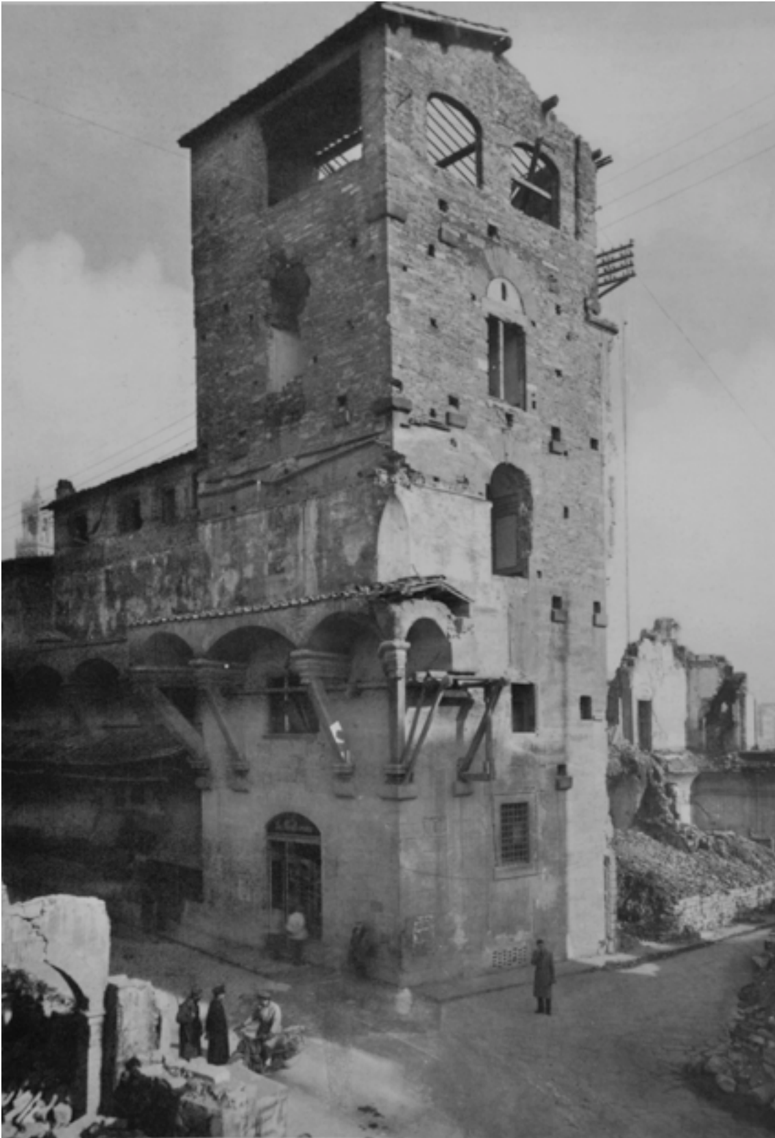
Fig. 37 Veduta della Torre dei Mannelli dal canto dei Guicciardini dopo il crollo dell'abitazione adiacente, autunno-inverno 1944. (da: Loris Macci e Valeria Orgera, Architettura e civiltà delle Torri. Torri e famiglie nella Firenze Medievale . Firenze: Edifir, 1994)
