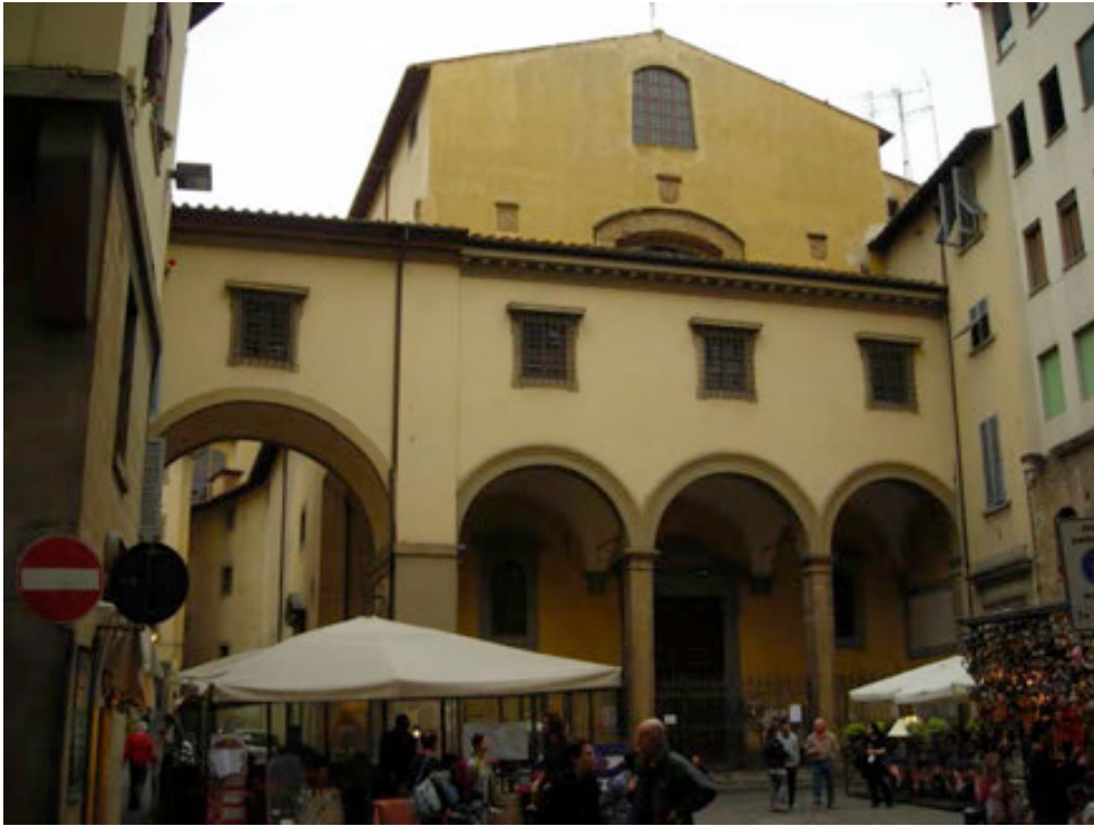
Fig. 152 Firenze, Chiesa di Santa Felicità , prospetto principale. (foto in rete)
