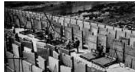
G. G. Gori, E. Gori, E. Nelli, R. Morandi, Ponte Amerigo Vespucci, Firenze, veduta del cantiere, 1953-1957
