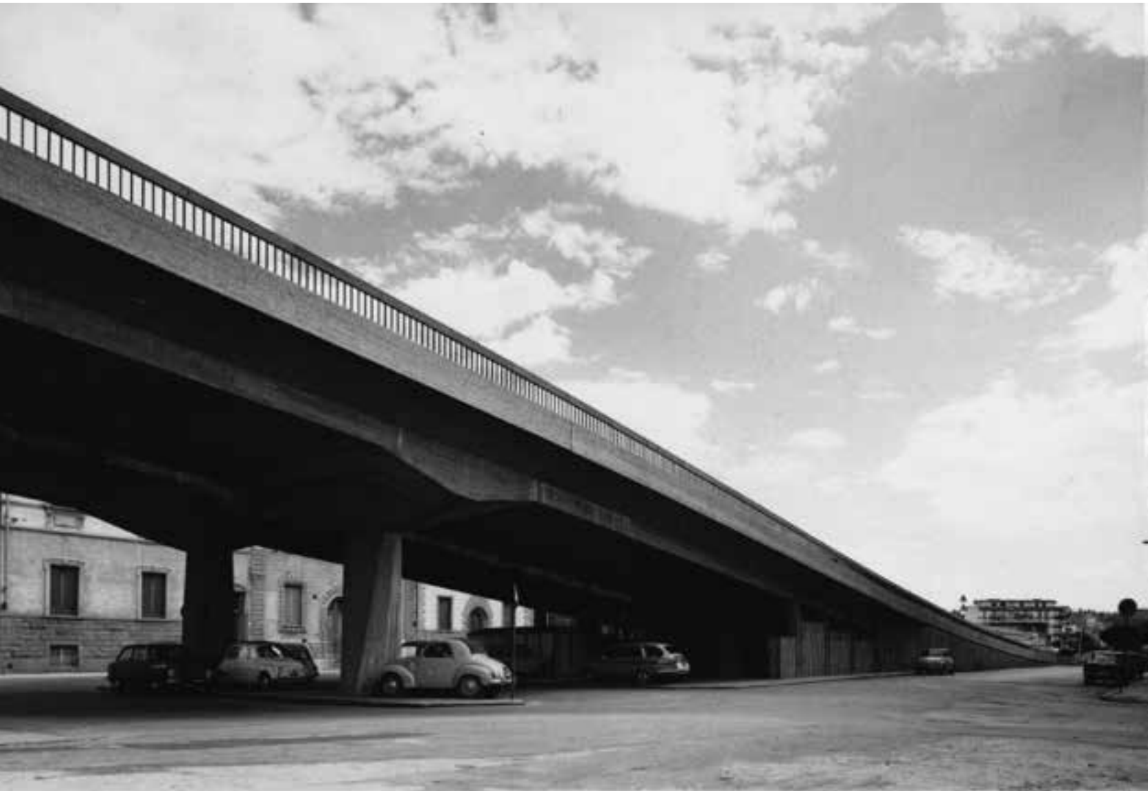
G. Gori, R. Vernuccio, S. Egoroff, Cavalcavia dell'Affrico, Firenze, vedute dello spazio sotto il ponte, 1964
