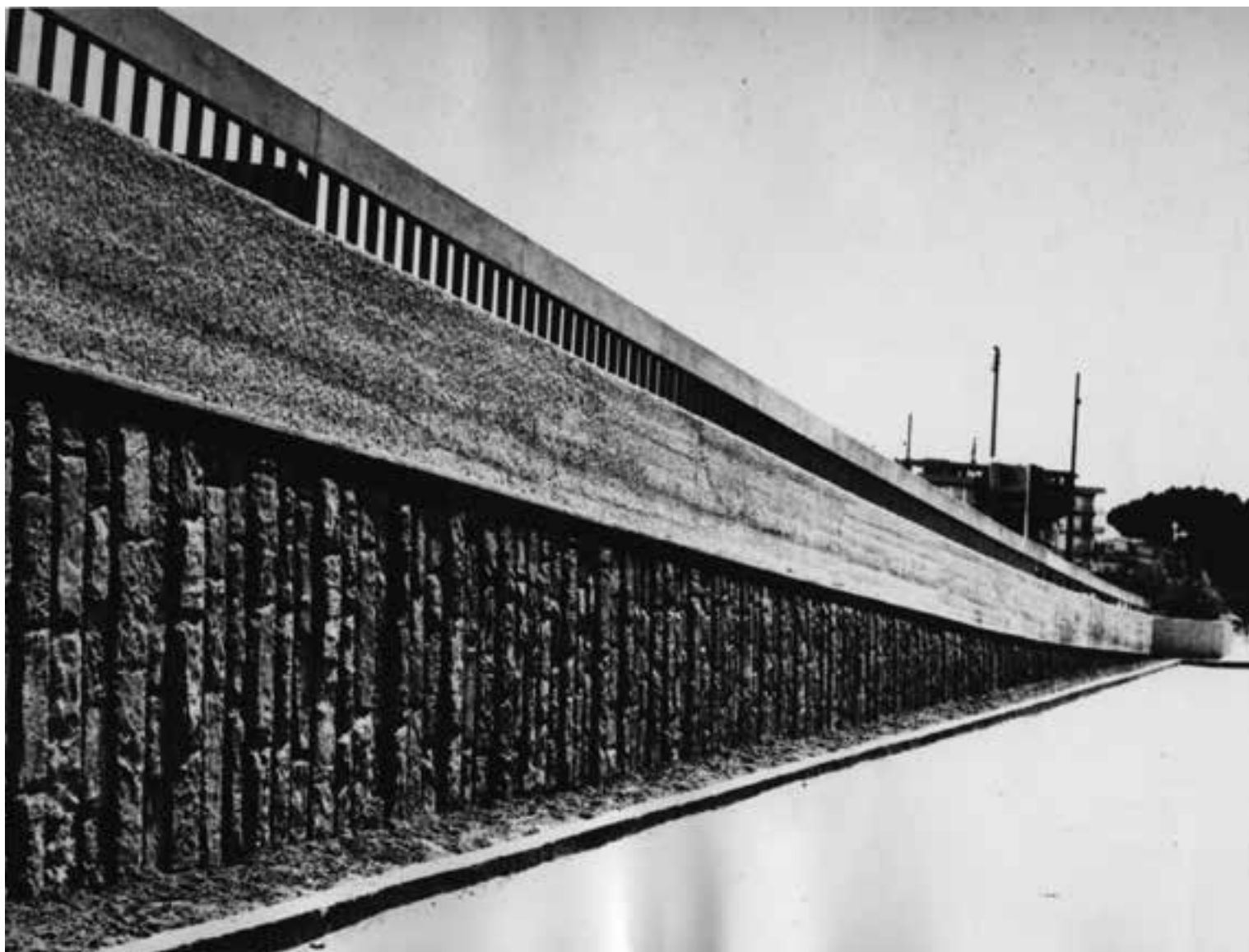
G. Gori, R. Vernuccio, S. Egoroff, Cavalcavia dell'Affrico, Firenze, veduta dell'attacco a terra del ponte, 1964
