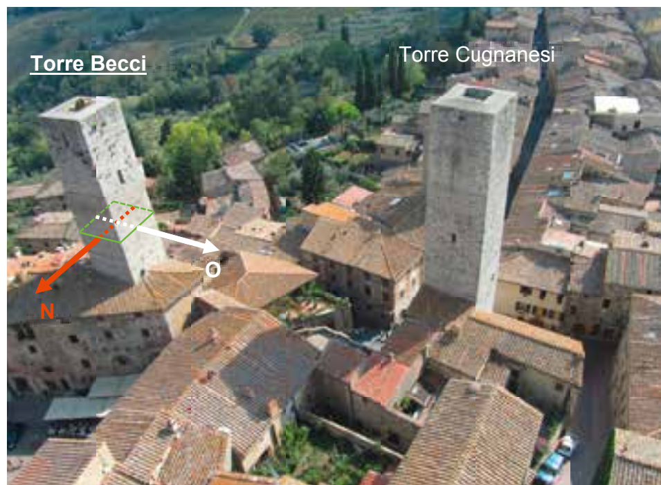
Figura 1 – Centro storico di San Gimignano, torre Becci e torre Cuganesi (N = direzione Sud-Nord; O = direzione Est-Ovest).
