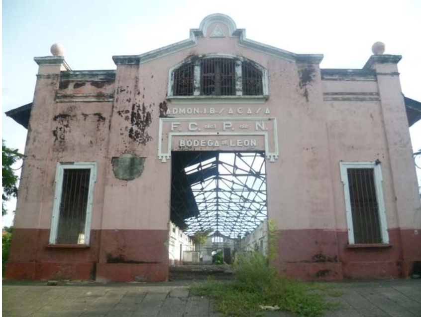
Image 1 – La Bodega de la Antigua Estación del ferrocarril de León before the intervention.
