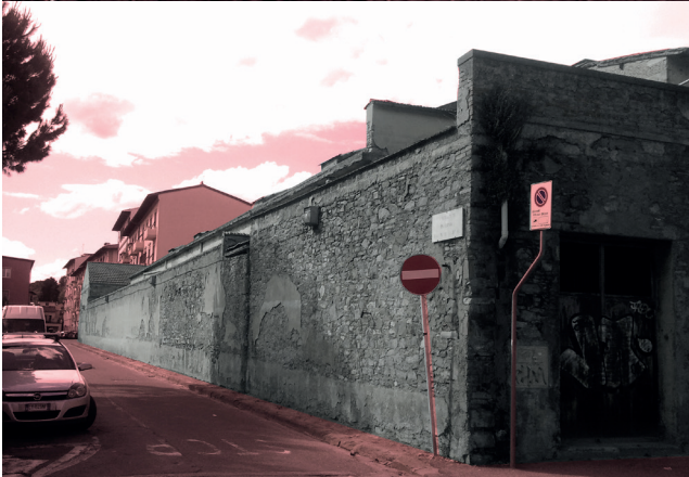
Cartiera abbandonata zona delle Cure
