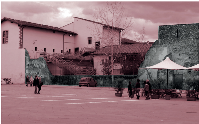
Muro perimetrale della sede del Dipartimento di Architettura in Largo Annigoni
