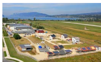
Fig.I.112 Immagine del test site di Ines. Credits: V. Renzi.
