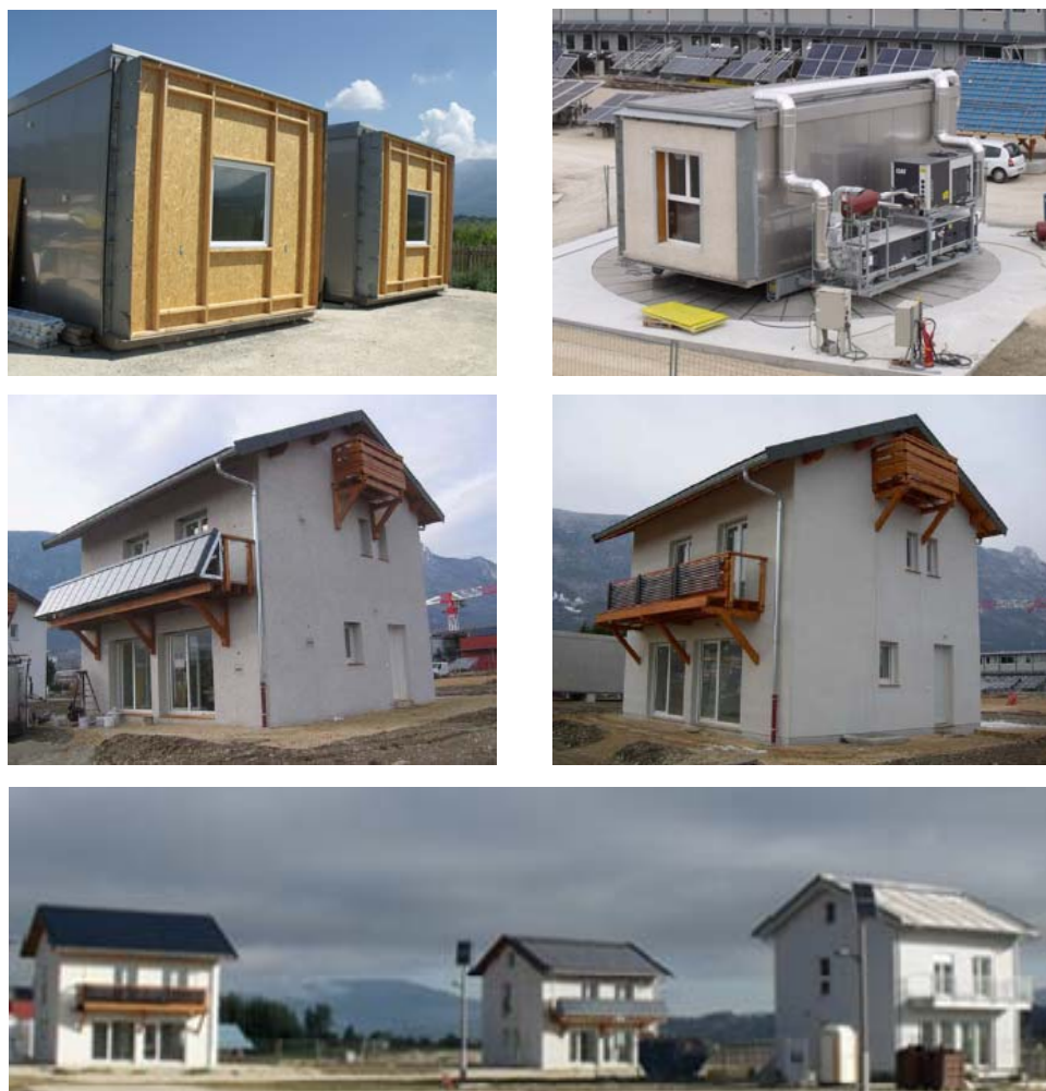
Fig.I.113. Il test site Ines, ha tre test cell di cui due sono del tipo PASSYS ed una Paslink, su piattaforma girevole. Tutte e tre le test cell sono state acquisite nel 2002 dal Centro di ricerca CEA e ristrutturare. Credits: V. Renzi.
