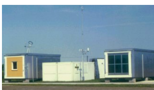
Fig.I.105. Immagini del test site di Porto. In evidenza il degrado delle test cell.
