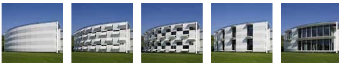
Fig. I.39 Facciate dinamiche: componenti di facciata opachi e trasparenti. Architect: Giselbrecht + Partner ZT GmbH. Kiefer Technic Bad Gleichenberg. Credis: Paul Ott
