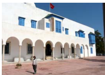
Fig.I.124. Porticati esterni per garantire ombreggiamento negli spazi urbani e quindi soluzioni alla ricerca del comfort termico. Maison baron d erlange, Sidi bou Said. Credits: Walid Saidane.
