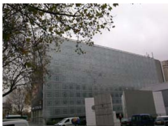
Fig.I.149. L'Istituto del Mondo Arabo, vista dall'esterno. Credits: R. Romano
