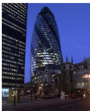
Fig.I.130. The Gerking. Vista dall'interno verso l'esterno.
