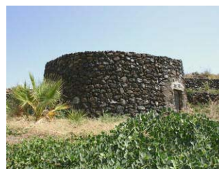
Fig.I.137. Il Giardino Arabo costruzione in pietra vulcanica, massiva, a protezione delle piante da frutto.
