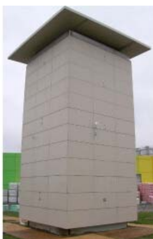
Fig. I.57. Il box per le misure all'aperto di pareti ventilate presso DIENCA
