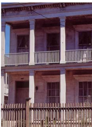
Fig.I.115. Porticati su edificio residenziale in periferia di Atene. Credits: M. Mouris
