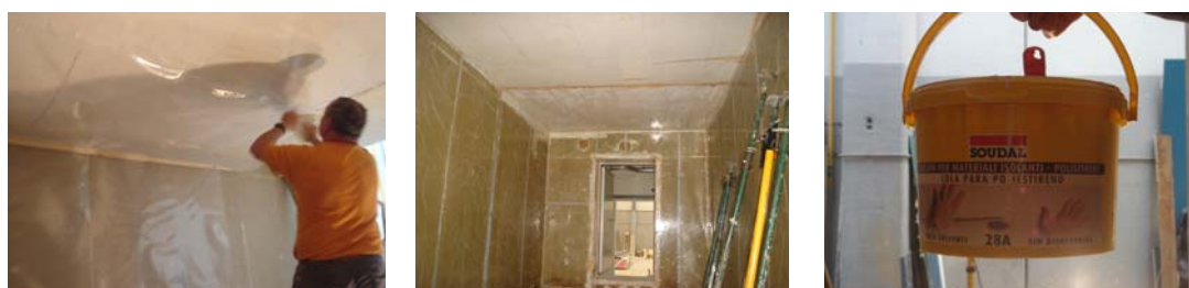
Figg.II.21, 22, 23. Installazione della barriera alle infiltrazioni durante le operazioni di ristrutturazione della test cell di Vitoria-Gasteiz. A destra, colla utilizzata.
