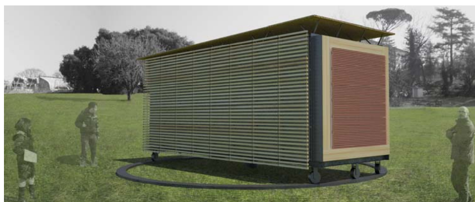
Fig. II.43. Facciata ventilata a schermo avanzato come nuovo componente da testare in condizioni climatiche esterne. Rendering: A. Di Zenzo
