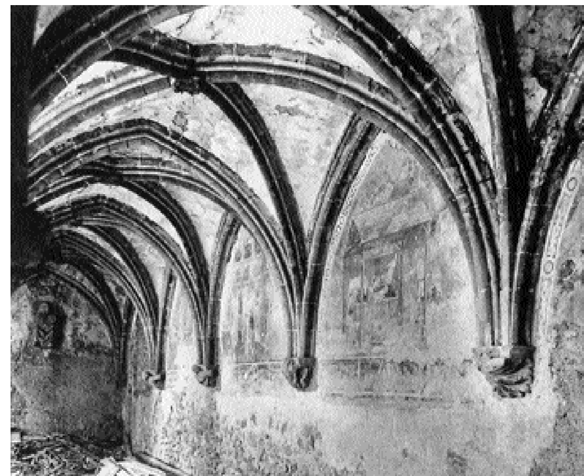
3. Abbazia di Abondance, chiostro, manica sud prima degli interventi di restauro
