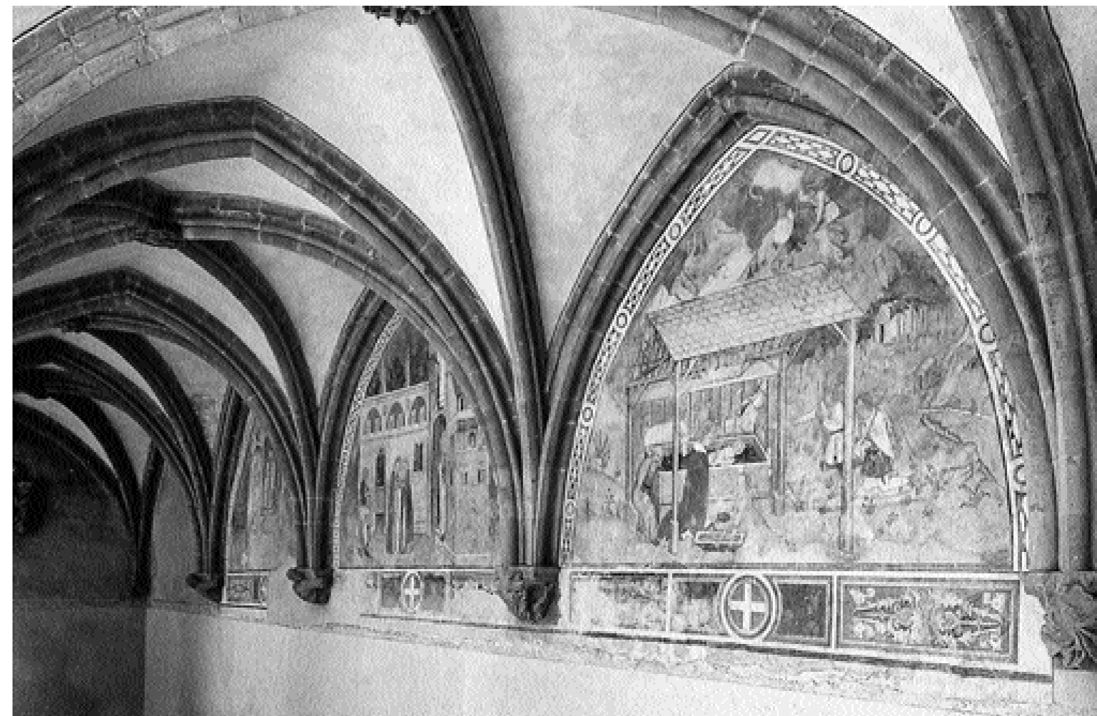
2. Abbazia di Abondance, chiostro, manica sud allo stato attuale
