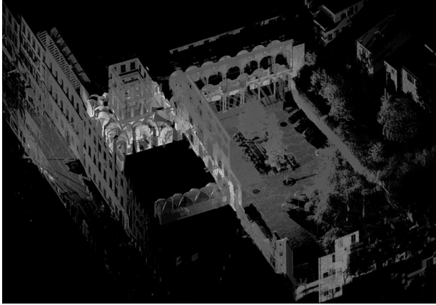
Fig. 10 - Nuvola dei punti degli ambienti esterni del Palazzo.
